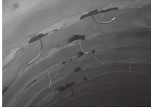
Şekil 4. Püskütme membran uygulaması öncesi su sızıntılarının geçici drenajı, Viret Tüneli (Verani ve Aldrean, 2010)
