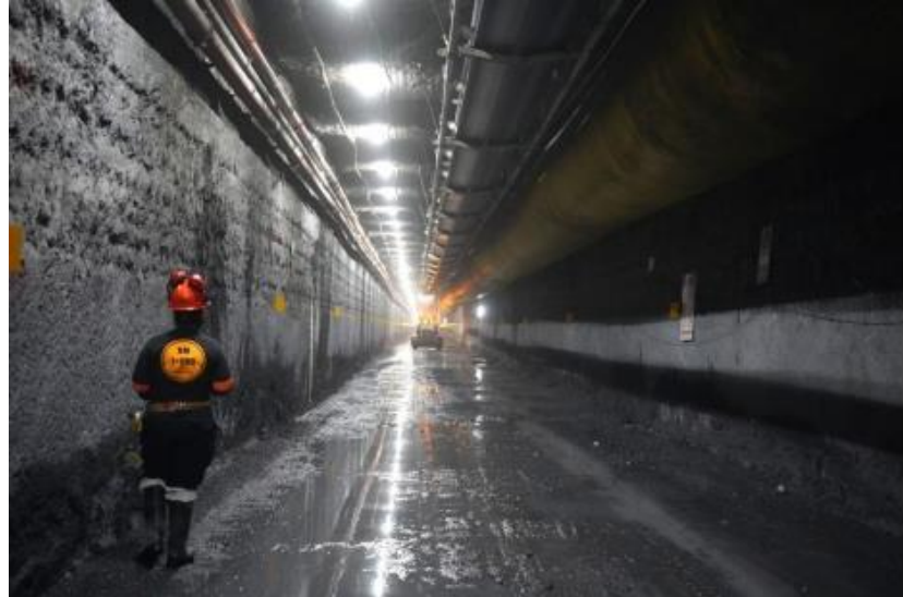
Şekil 9. TBM MDM5000 ile Fresnillo gümüş madeninde açılan galeri
