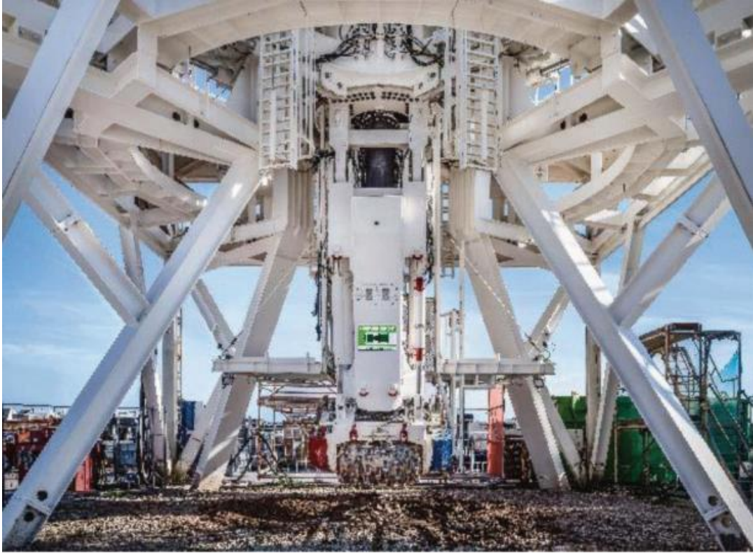
Şekil 3. Kuyu ekipmanını en altına yerleştirilmiş roadheader
