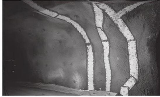
Şekil 5. Püskütme membran uygulaması öncesi aktif su girişlerinin yönetimi, Hirtenberger Mühimmat Deposu (Verani ve Aldrean, 2010)
