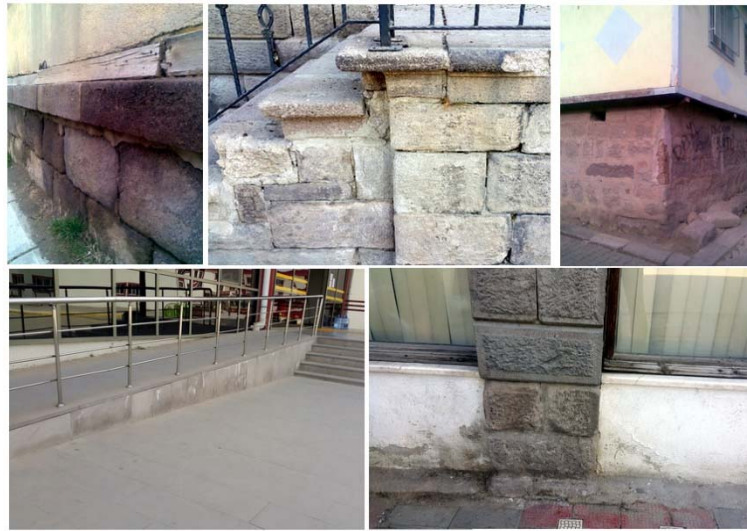
Şekil 1. Afyonkarahisar yöresinde andezitlerin yapı taşı olarak kullanımına örnekler ve andezitlerde görülen ayrışmalar
