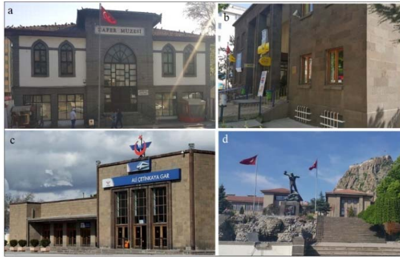
Şekil 11. İsehisar andezitlerinin Cumhuriyet dönemine ait anıt ve yapılarında kullanılması, a) Zafer Müzesi (1920), b) PTT binası (1940), c) Afyon Gar binası (1939), d) Utku anıtı (1936)
