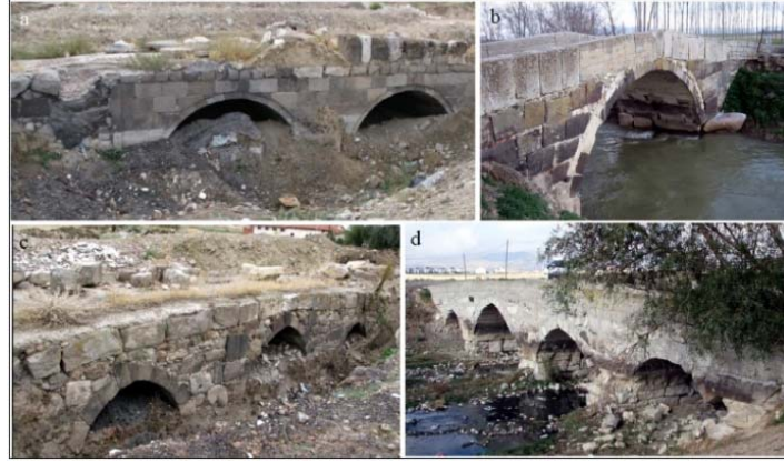
Şekil 10. Afyonkarahisar'da yapı taşı olarak andezit ve diğer taşların kullanıldığı Osmanlı dönemi köprüleri a) İkiğöz Köprüsü, b) Kanlıgölet Köprüsü, c) Harmancık köprüsü. d) Kurşunlu Köprü (İnt. Kaynak 2, 2019)
