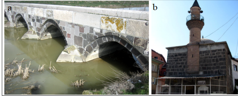
Şekil 8. Afyonkarahisar’da bulunan andezit kullanılarak yapılan Selçuklu dönemi eserleri a) Altığöz Köprüsü (1209), b) Yukarıpazar camii (1264)
