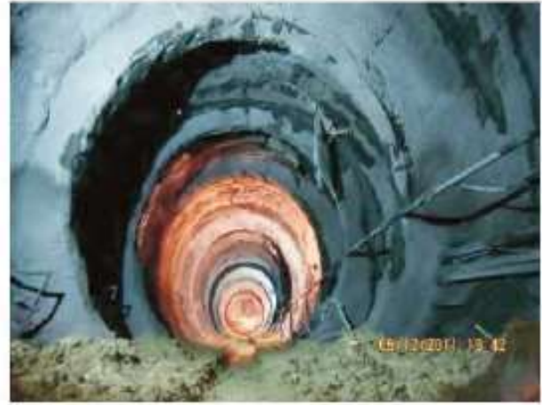
Şekil 33. İmalatı tamamlanan güçlendirme ringleri
