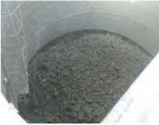
Şekil 12. Patlatma sonrası shaftın görünüşü
