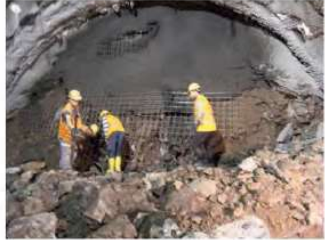
Şekil 6. Kazı aynasının kapatılması
