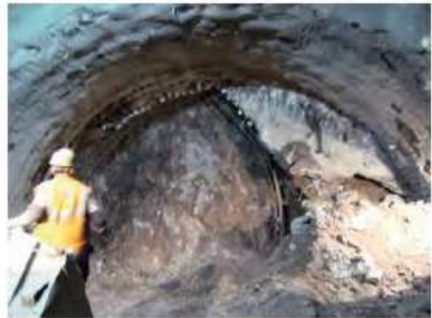
Şekil 9. Tünel aynasının parçalara bölünerek kazılması
