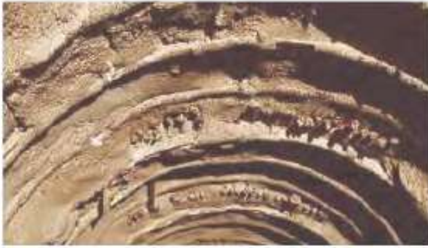
Şekil 7. Tünelde çok zayıf formasyonda uygulanan sürenli tahkimat sistemi
