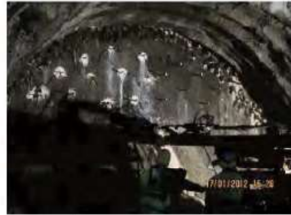
Şekil 30. İbo tipi zemin çivisi uygulaması
