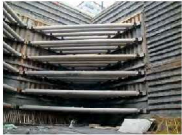
Resim 9. Kazı Faaliyetlerinin Tamamlanması Ardından Çelik Boru Strut Görünümü
