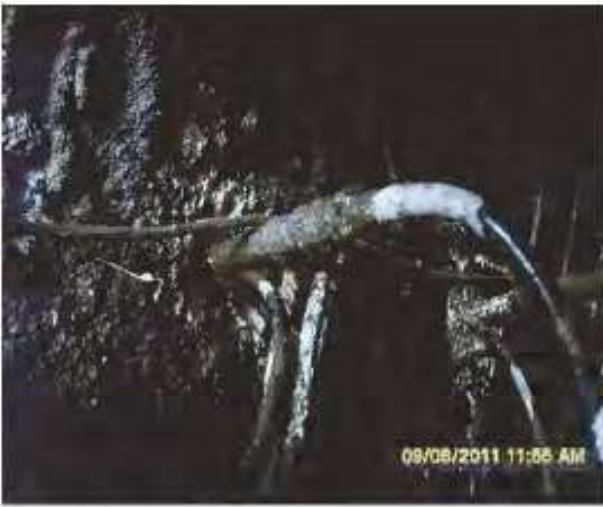
Şekil 28. İbo bulon enjeksiyonu
