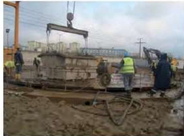
Şekil 4. Patlatma öncesi kapak montajı
