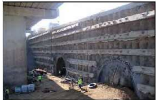
Şekil 8. Yerleştirilen boruların tamamlanması
