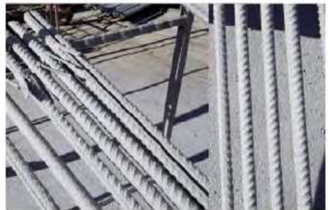
Şekil 10. Kaplanmış ribar yüzeyleri
