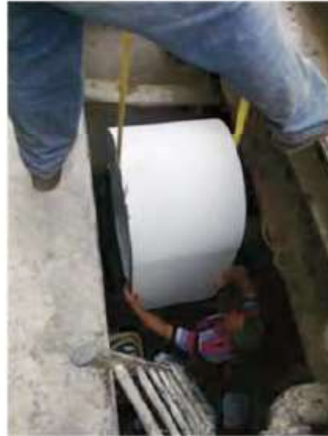
Şekil 11. Parçanın tünele indirilmesi (Yavuz, 2012)
