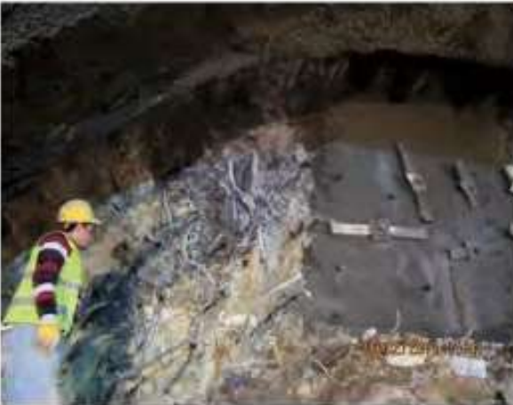
Şekil 24. Parçalı kazı
