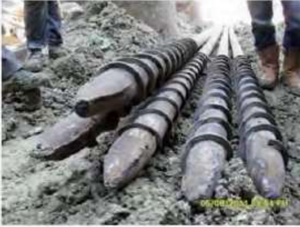
Şekil 15. Vida tipi umbrella imalatı tamamlanmış borular
