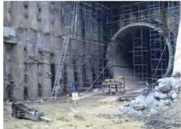
Şekil 3. Dayama duvar ve kuşak imalatı
