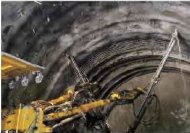
Şekil 5. Tavanda kaya saplama delikleri için yapılan delik delme işlemi
