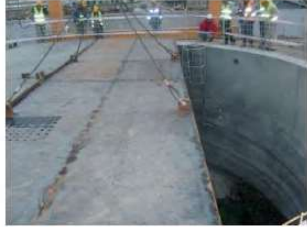
Şekil 2. Patlatma öncesi kapak montajı
