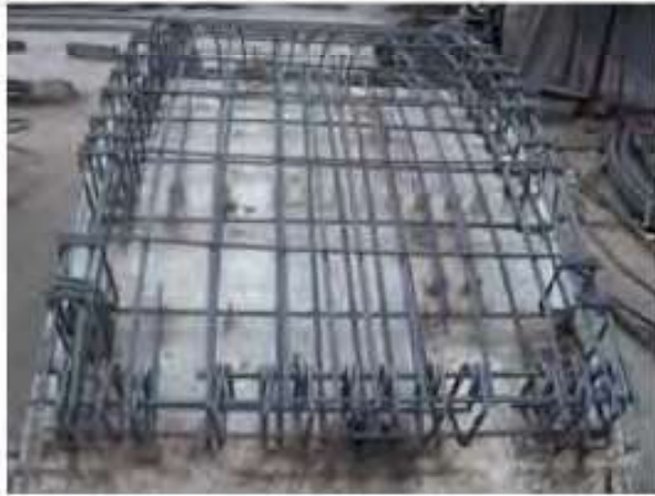
Şekil 13. Hazırlanan donatı kafesi (Bezgin, 2009).
