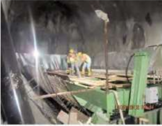
Şekil 35. İnvart betonu dökümü
