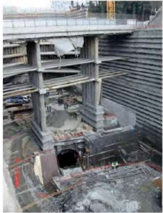
Resim 6. Mini Kazık Çerçeve Sistemi İle Birlikte Köprü Ayakları Görünümü
