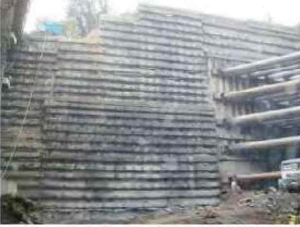
Resim 10. 18-28 Aksları Arası İksa Görünümü
