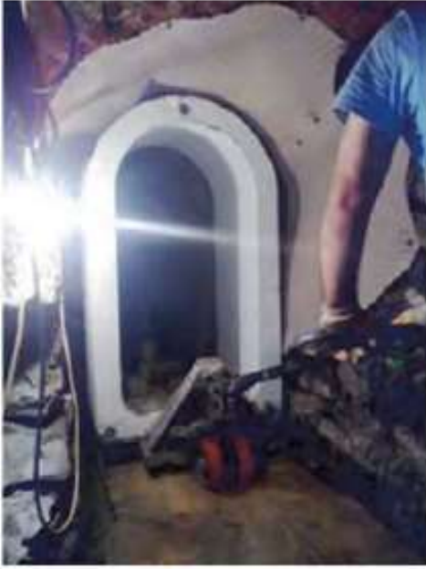
Şekil 12. Parçanın tünele yerleştirilmesi (Yavuz, 2012)
