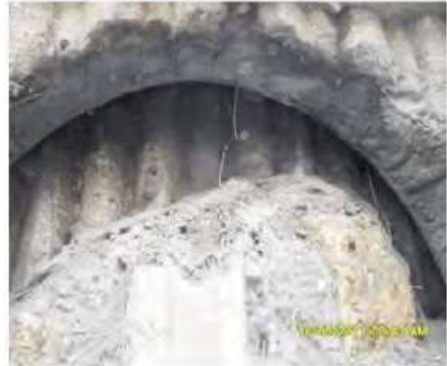
Şekil 7. Turn Back tüneli girişinde bulunan iki sıra fore kazık
