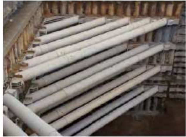
Resim 8. 4 Kademe Çelik Boru Strut İmalatı
