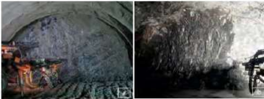
Şekil 2. Cankurtaran tüneli tünel aynaları a) tünel girişi b) tünel çıkışı
