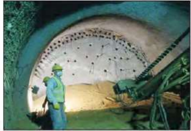
Şekil 11. Çivilerin takılmış hali
