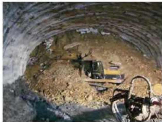
Şekil 3. Göçükten hemen sonra çekilmiş fotoğraf (Onargan vd., 2013)
