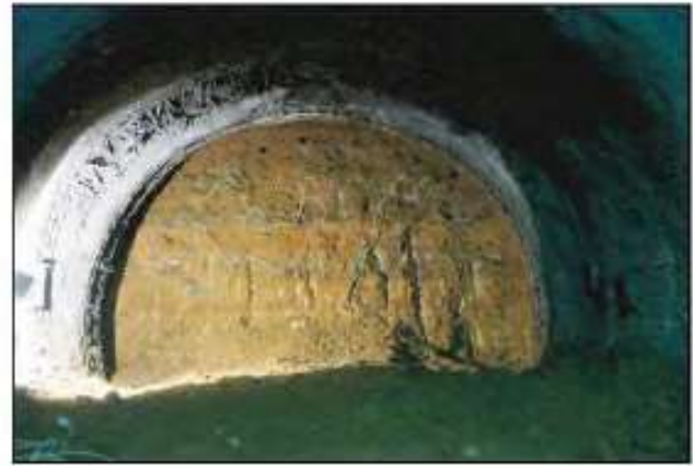
Şekil 13. Sıkıştırılmış dolgu
