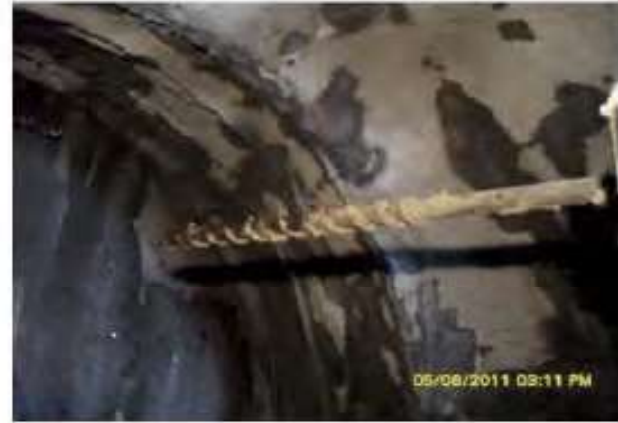
Şekil 13. Vida Tipi umbrella borusu delgisi ve montajı
