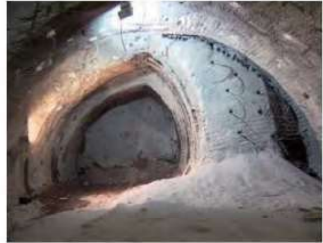
Şekil 10. Parçalı kesitte ano kazısının tamamlanması
