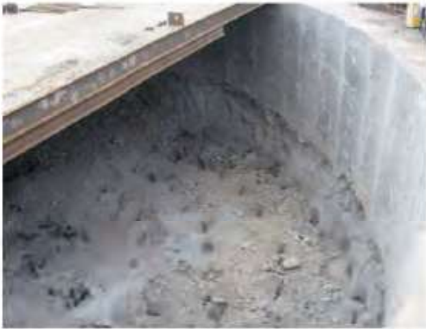
Şekil 9. Şaft başlık kirişi betonu sonrası ilk patlatma için hazırlanan üretim delikleri.
