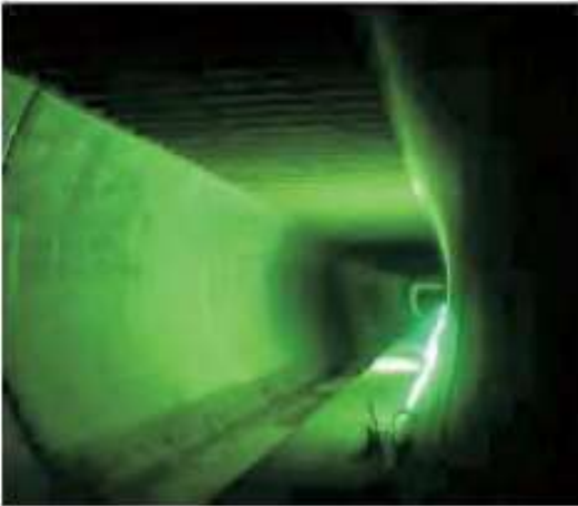
Şekil 37. İmalatı biten Turn Back tüneline girilme görünümü
