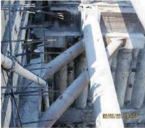
Şekil 5. Yapıyı desteklemek için yaptığımız strut imalatı
