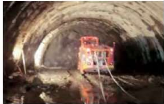
Şekil 3. Üzülmöz tüneli portalleri ve arınından görünüm
