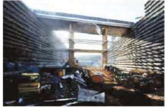
Resim 5. Burkulmayı Önleme Amacıyla Yapılan Çelik Boru Strut Destekle Sonrası Köprü Görünümü
