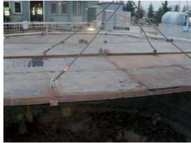
Şekil 3. Patlatma öncesi kapak montajı
