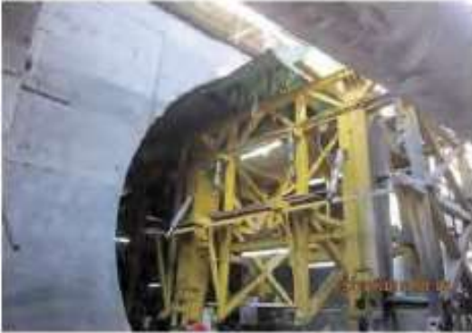
Şekil 36. Çelik kalıp demontajı
