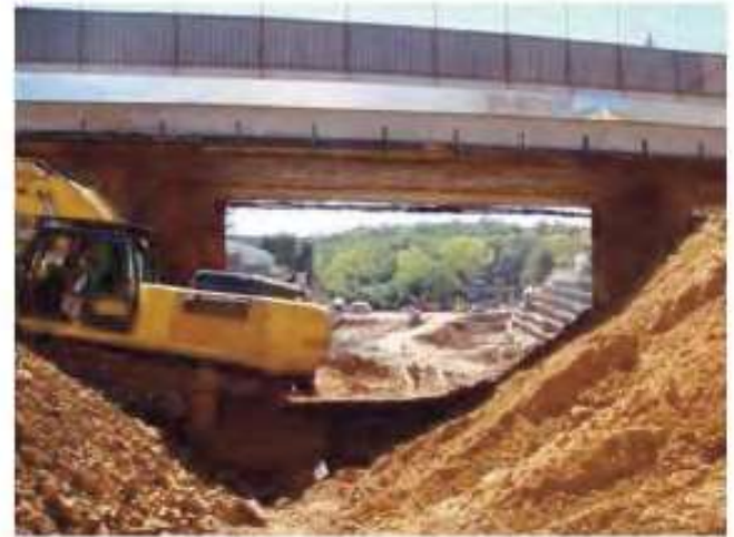
Resim 3. Köprü Altı Kazının Yapılması Sonrası İlk Gör
