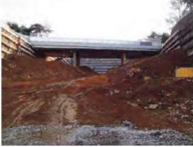
Resim 4. Köprünün 1 – 18 aksları bölgesinden görünümü
