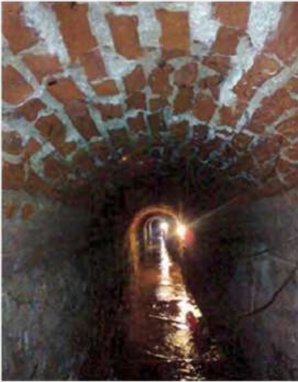
Şekil 1. Tünel iç görünüm (Bezgin, 2012)
