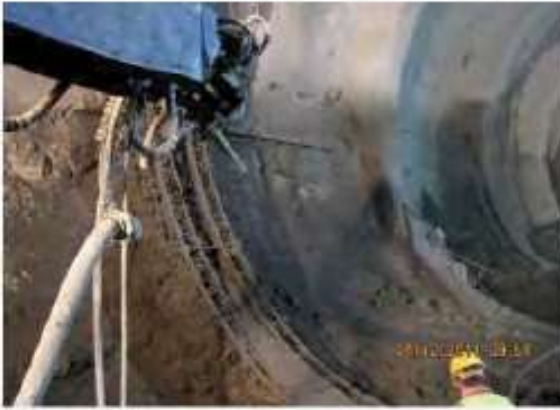
Şekil 32. Güçlendirme ringi shotcrete atımı
