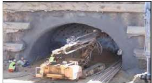
Şekil 7. Çelik borular yerleştirilmesi
