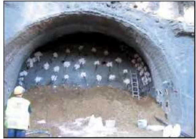
Şekil 10. Zemin çivilerinin kurulumu
