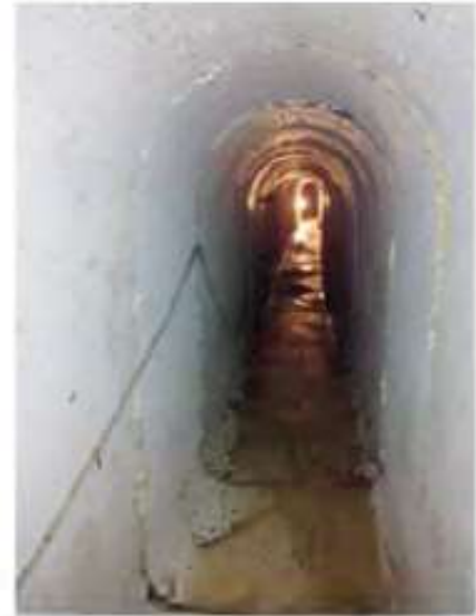
Şekil 16. Tamamlanan tünel (Yavuz, 2012)
