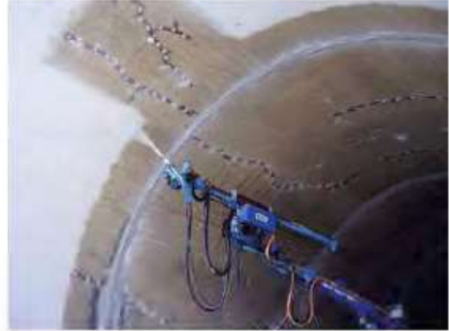
Şekil 6. Püskürtme poliüre su yalıtım kaplaması
