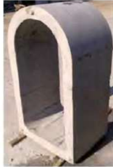
Şekil 6. Tüneli oluşturan yapısal birim (Bezgin, 2012)
