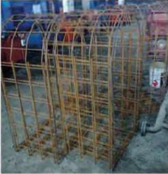
Şekil 3. Hasır donatı kafesleri (Bezgin, 2012)
