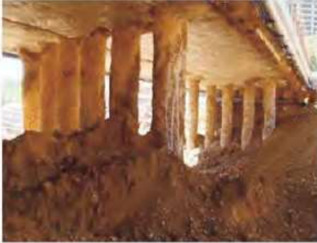
Resim 2. Köprü Orta Kazıkları, Kazı Sonrası
