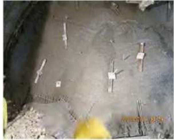
Şekil 25. İmalatı tamamlanmış zemin çivileri
