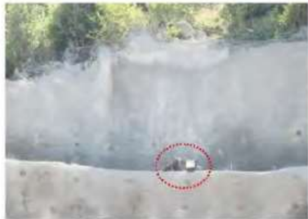
Şekil 11. Patlatma sonrası sol tünel portal seviresi üstüne üst yamaçtan yuvarlanarak düşen kaya bloğu
