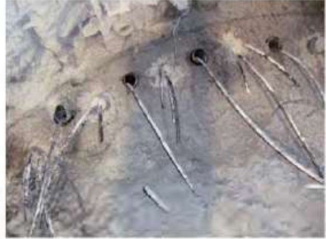
Şekil 8. Kemer borularının yerleştirilmesi
