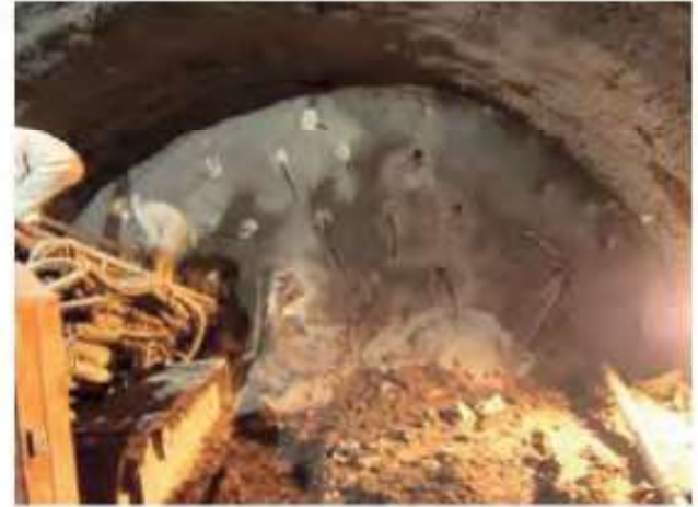
Şekil 7. Ayna çivilerinin yerleştirilmesi
