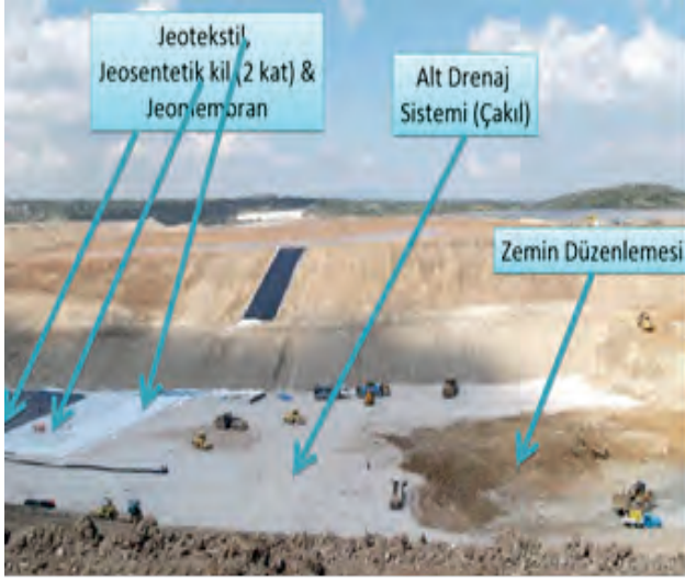
Şekil 3. Atık depolama için malzeme serme işlemleri (Karaca, 2012)
