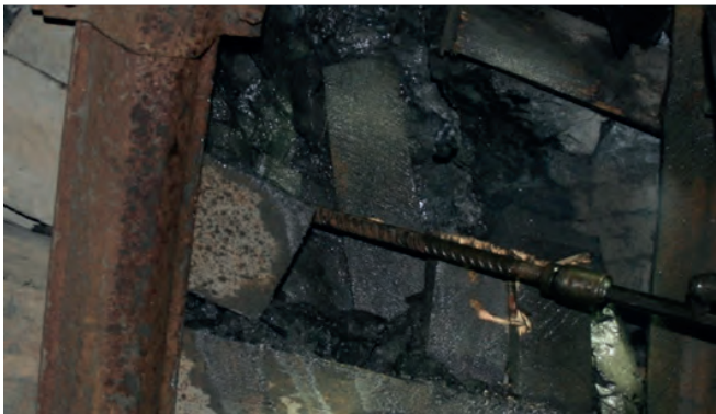
Şekil 7. Saplama çubuklarının delik içerisine yerleştirilmesi.
