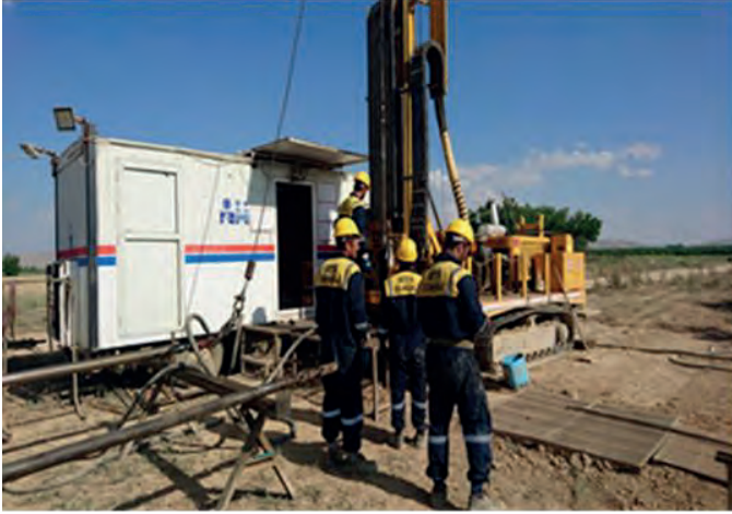
Şekil 5. Rezerv sondajı çalışmalarından bir görünüm.
