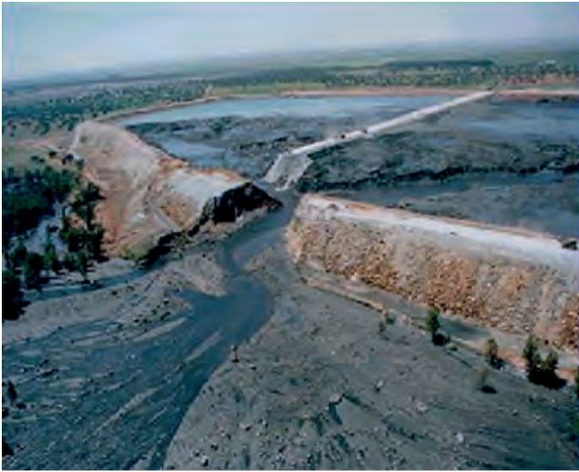
Şekil 2. Atık barajı kazası (Karaca, 2012)
