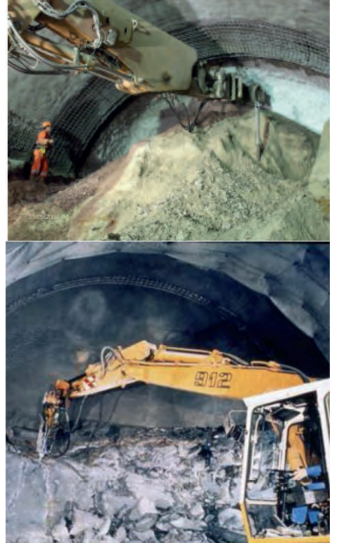
Şekil 11. Yapay zemin dondurma yöntemi ile zemin iyileştirmesi yapılmış bir tünel inşaatında kazı aşaması
