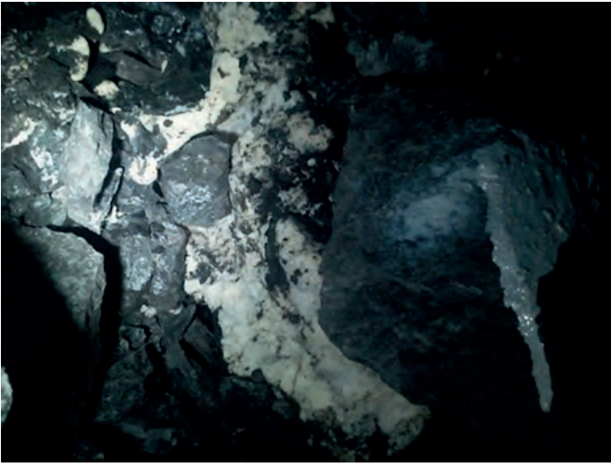
Şekil 9. Ön delgi deliklerinde enjekte edilen polimerin arını sağlamlaştırması
