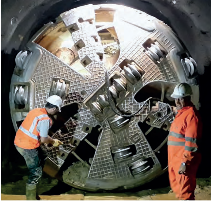
Şekil 3: TBM ön cephe görünümü
