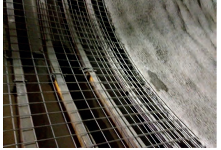
Şekil 14. Tünelin stabilitesini sağlamak için uygulanan ek tahkimat şekli
