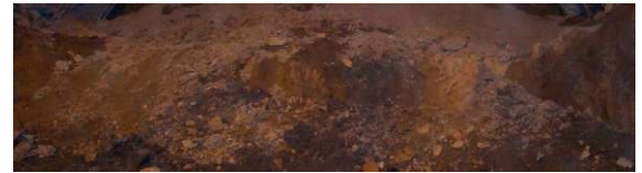
Şekil 5. İzmir Metrosu Üçyol-Üçkuyular hattı istasyon tüneli kazısında meydana gelen ayna
