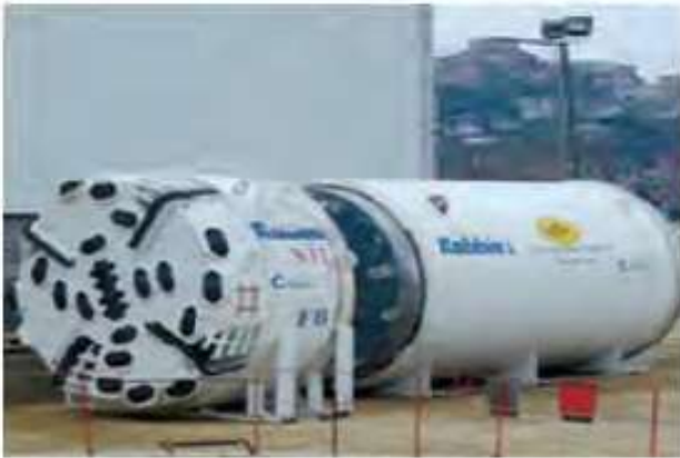
Şekil 3. Beykoz-Kavacık Paşabahçe Tünelinde Çalışan TBM (Güçlücan vd, 2007)
