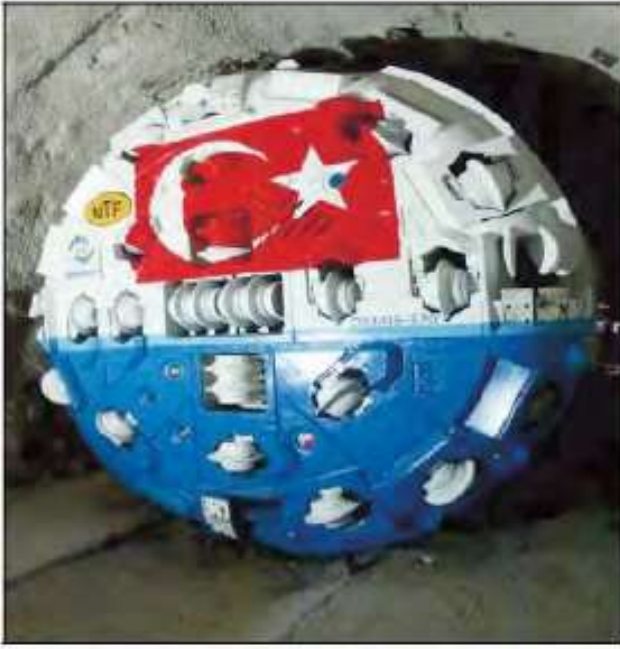
Şekil 2. Yamanlı II HES Projesi 1. Kademe Enerji Tüneli'nde kullanılan çift kalkanlı TBM (Robbins)
