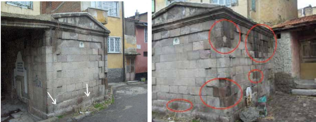
Şekil 12. Arapmescit çeşmesinde kayalarda görülen fiziksel bozunmalar.
