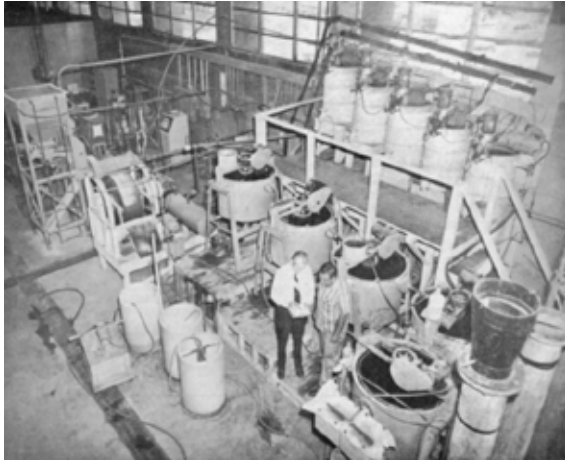
Resim 4. Elektro-oksidadasyon pilot tesisi (A.B.D. Madencilik Bürosu, USBM)
