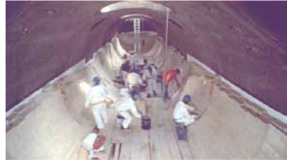
Resim 3. Otoklav içerisine asite dirençli tuğlaların döşenmesi
