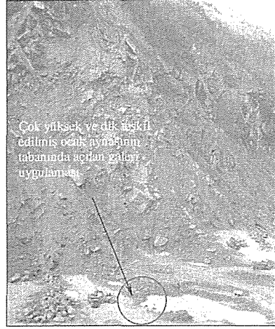
Şekil 3. Çok dik ve yüksek teşkil edilmiş ocak aynasının tabanında açılan galerî uygulaması
