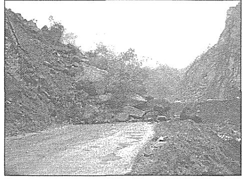
Şekil 18. Ocak sahasında meydana gelen heyelan sonucu yolun kapanması
