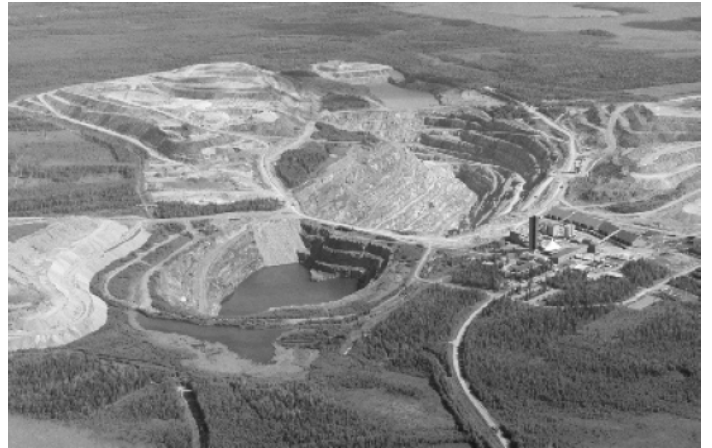
Şekil 1. Sağ tarafta bulunan arıtma tesisli iki açık maden ocağının üstten görüntüsü
