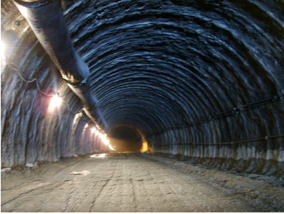
Şekil 9. Domabahçe-Dolapdere-Piyalepaşa Kağıthane Tünellerinden Bir Görünüş
