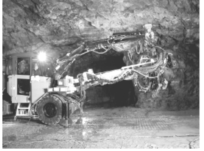
Şekil 7. Atlas Copco Boltec LC çalışma esnasında
