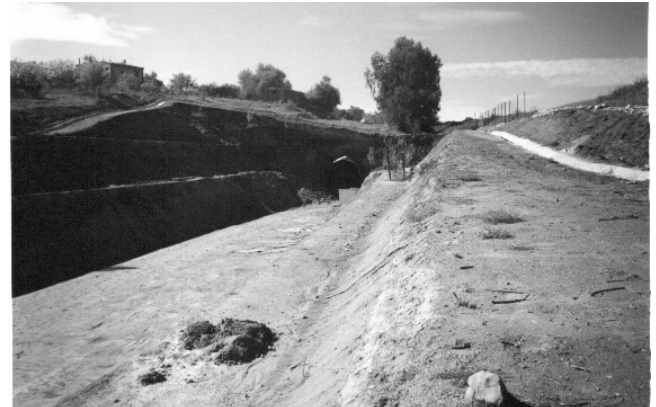
Şekil 12. Tünel portalında daha önce yapılan kazı çalışmalarından görüntüler
