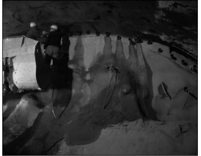
Şekil 8. Tünelin Göcek ağzında şemsiye borusu ve zemin çivisi yerleştirme işlemi
