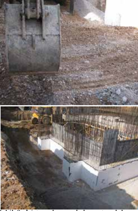
Şekil 9. İri tane karışımı kırmataş dolgu ve uygulamanın yapıldığı temel içinin genel görünümü.
