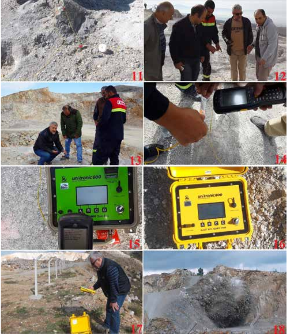
Şekil 14. Elektronik ateşleme sistemi esnasında deliklerin hazırlanması: (11): elektronik kapsüllerin hatlar boyunca bağlanmış hali, (12): elektronik kapsüllerin gecikme aralıklarının belirlenmesi, (13): elektronik kapsüllerin lazerli el tarayıcı (Scanner) ile okunması, (14): elektronik kapsülün üzerindeki barkodun lazerli el tarayıcı (Scanner) ile okunma görüntüsü, (15): el tarayıcısının elektronik manyeto'ya aktarılması, (16) uzak noktadaki kablosuz manyeto, (17): uzak noktadaki kablosuz manyeto'ya son veri kontrol edilmesi (18): Elektronik ateşleme sonrası patlatma görüntüsü
