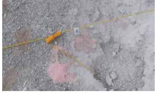
Şekil 9. Elektriksiz kapsül uygulaması
