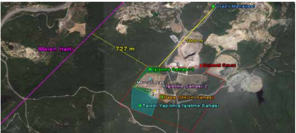
Şekil 2. İşletme Ruhsat Alanı, İşletme Sahası, Çevre Bölgenin Genel Görünümü ve Riskli Yapılara Olan Uzaklıklar (Özer vd. 2016)
