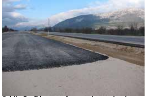
Şekil 7. Dinar – Isparta karayolunda üst temel malzemesi olarak kullanılan dolgu malzemesi ve yol çalışmalarından görünüm.
