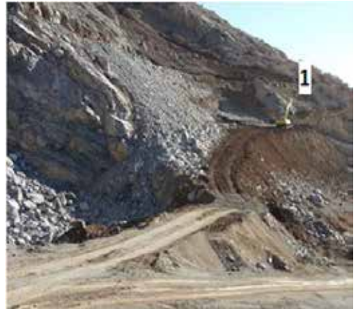
Şekil-8: 1'de ekskavatörün basamak oluşturma çalışmaları
