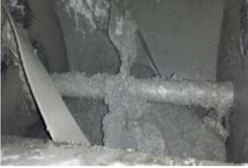
Şekil 3. Taze betonun mikserde karıştırma işlemi
