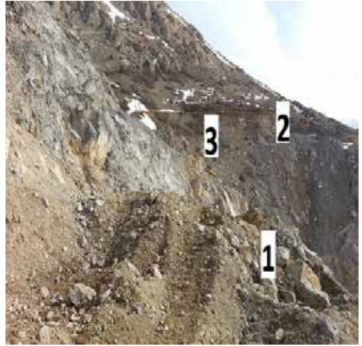
Şekil-3: 1 ve 2'de ocağın zirve noktasında yapılan patlatma, 3'de ise ekskavatörün alana gelmesi
