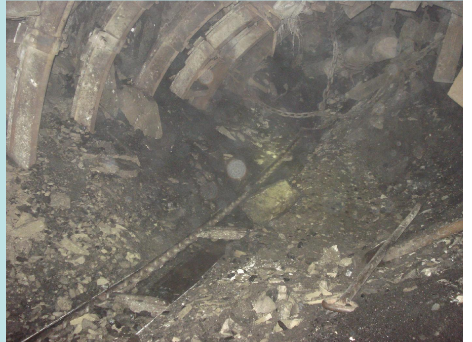
Ara kat göçertme bacası
