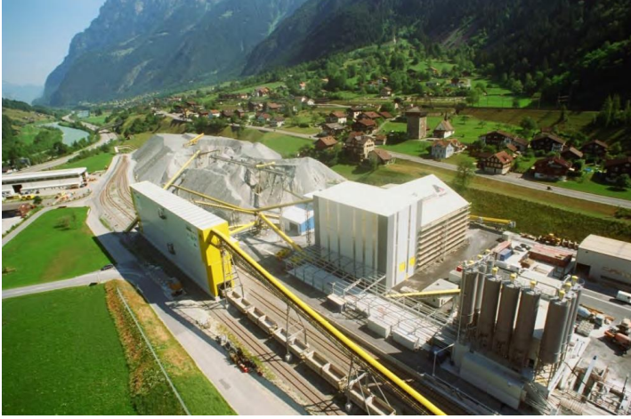
Şekil 8. Tünel kazısından çıkarılan malzemenin agrega üretimi
