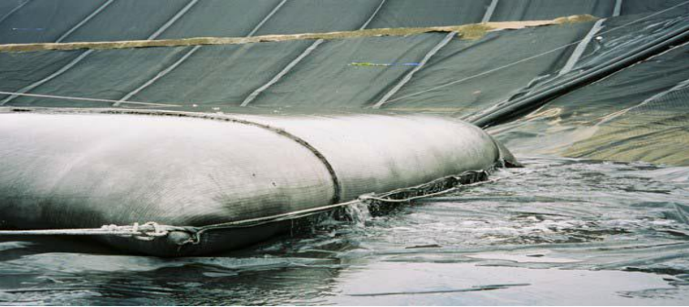
Şekil 3. Jeotekstil malzeme ile susuzlaştırma işlemi (Newmanvd., 2004)
