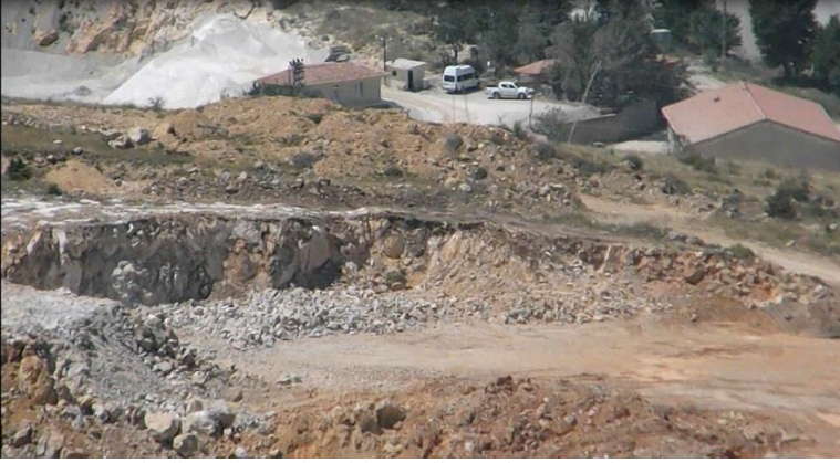
Şekil 4. Çorum Belediyesi şantiye binası ile çalışma sahası taşocağının görünümü
