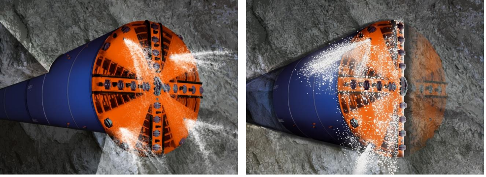
Şekil 6. Zemin iyileştirmede TBM köpük uygulaması
