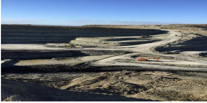
Şekil 1. Açık ocak şev ve basamak oluşturma çalışmaları
