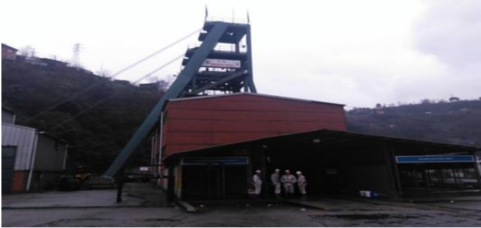
Şekil 5. Kuyu tesislerinden görünüm
