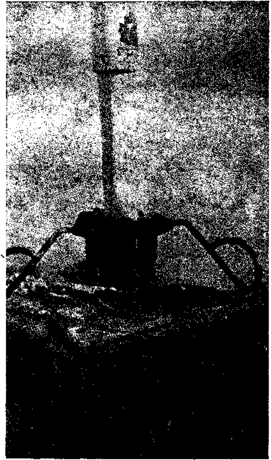
KDIA test kuyusunda fişkırmaya geldikten sonra sondaj borusu
