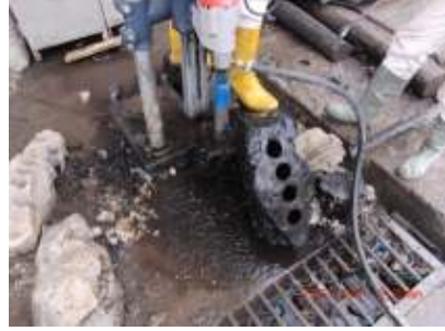
Şekil 3. Karotiyer ile Karot alınması
