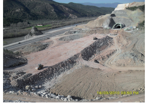
TÜNEL GİRİŞ PORTALI VE GÜZERGAH DOLGULARI
