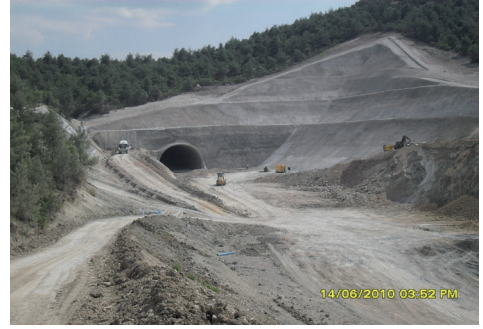
TÜNEL GİRİŞ PORTAL VE YAN ŞEV İMALATLARI
