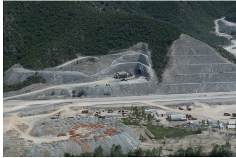
DEMİRYOLU TÜNELİ VE KARAYOLU YARMA ŞEVLERİ
