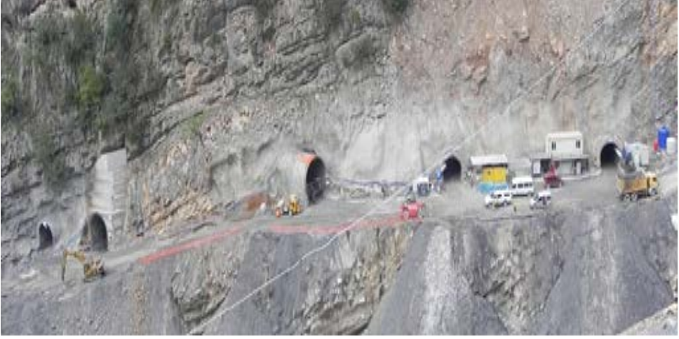
Şekil 2. HES iletim tünelleri
