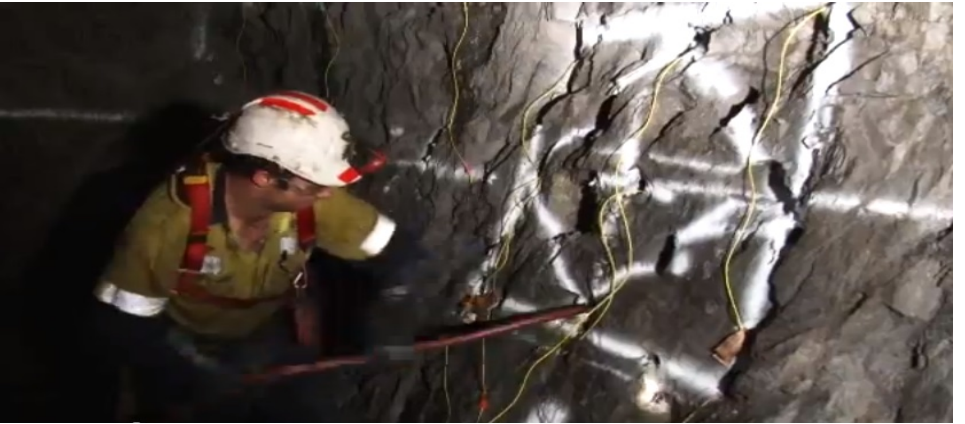
Şekil 23. Tünel aynasına patlayıcıların yerleştirilmesi
