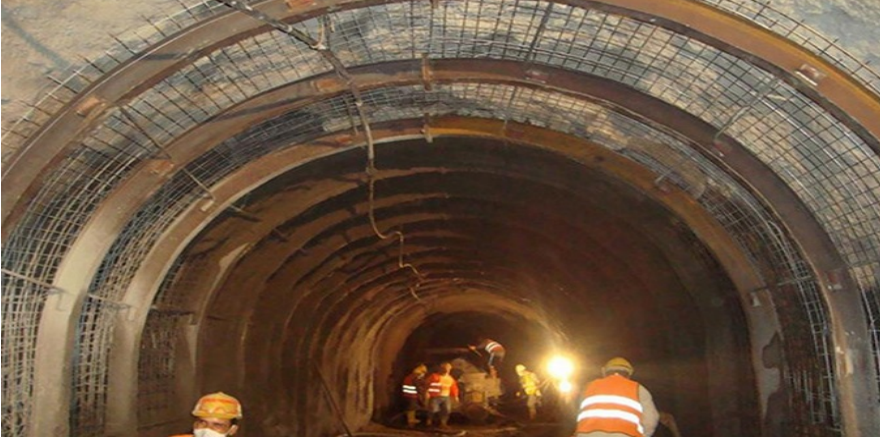
Şekil 16. Tünel içinde iksa, çelik hasır ve püskürtme beton.
