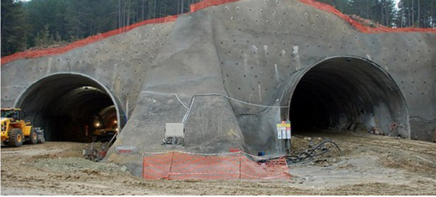
Şekil 6. Tünel Giriş yapısı, tünel portali
