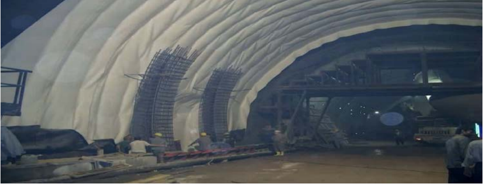
Şekil 24. Tünel içi kalıp çalışmaları
