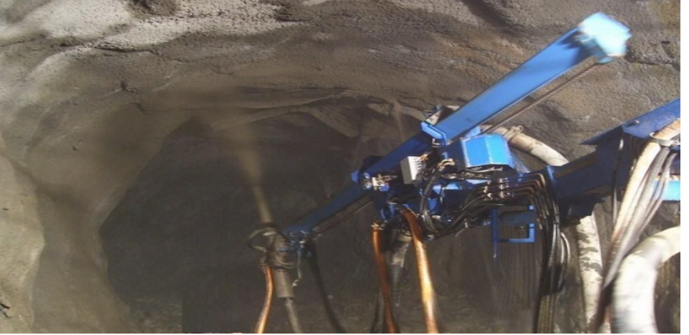
Şekil 22. Tünel içi beton püskürtme
