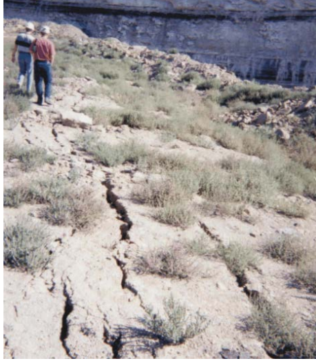
Şekil 2. Döküm Alanının Kenarında Meydana Gelen Gerilme Çatlakları (Camm, 2000)
