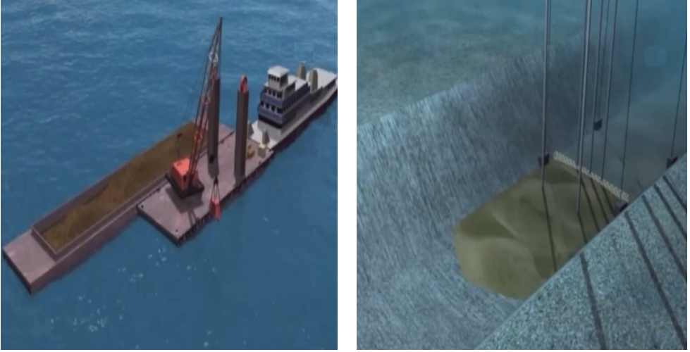
Şekil 12. Batırma tüneller için oluşturulan trapez çukurlar
