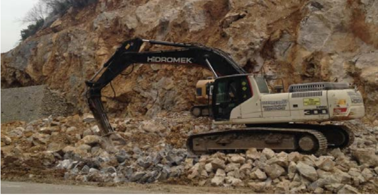
Şekil 7. Bölünmüş yol çalışmasında kullanılan hidrolik kırıcı
