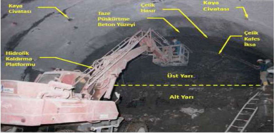
Şekil 14. NATM yöntemiyle açılan tünel içindeki çalışmalar
