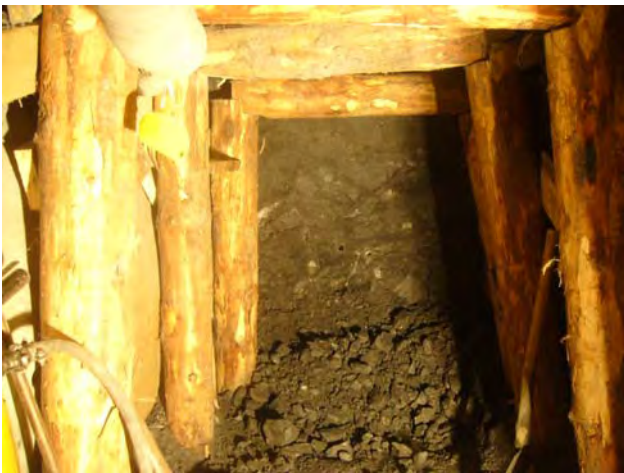
Şekil 4. Bloke olan kesici kafayı kurtarmak için açılan galeri ve sıkışmaya neden olan dasit daykı
