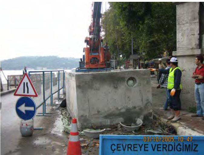
Şekil 7. Prekast Kuyu
