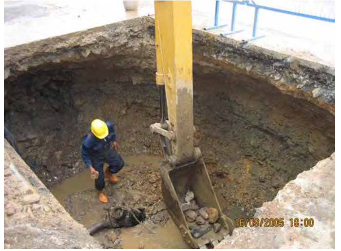
Şekil 3. Kepçe ile Kuyu Kazısı
