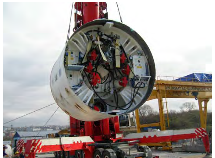
Şekil 2. Ambarlı Atıksu Tüneli'nde Kullanılan Herrenknecht EPB-TBM
