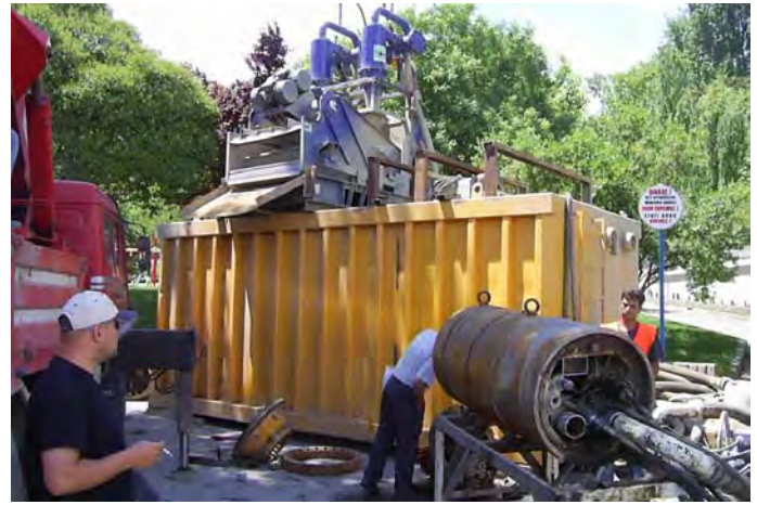
Şekil 12. Çamur Tankı ve Katı-Sıvı Ayrımı
