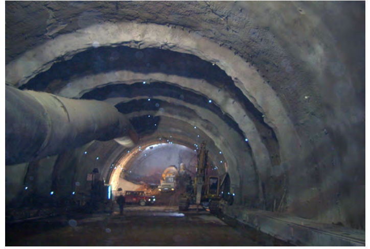
Şekil 10. Elmalık sol tünelde deprem öncesi yapılan kuvvetlendirme çalışmaları
