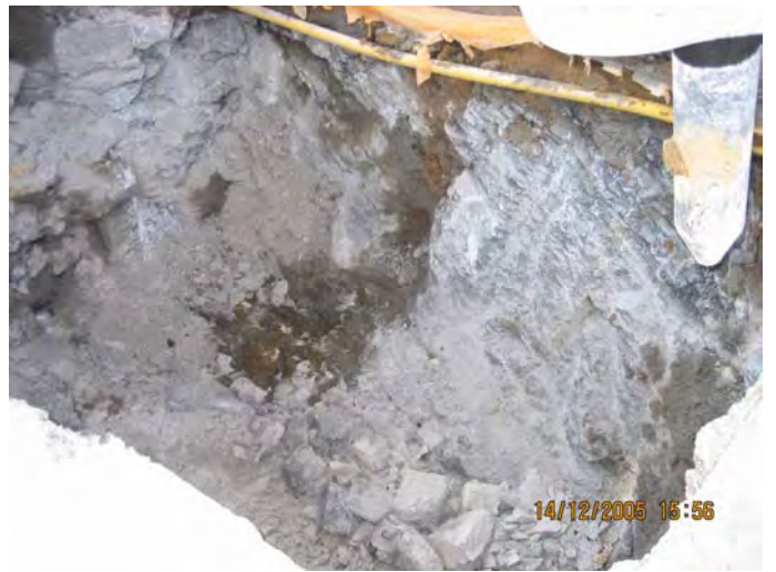
Şekil 4. Hidrolik Kırıcı ile Kuyu Kazısı
