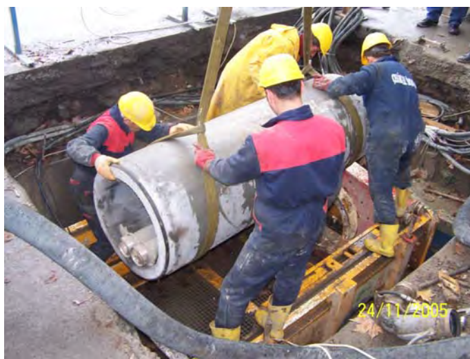
Şekil 2. Borunun İtme Kuyusuna Alınması
