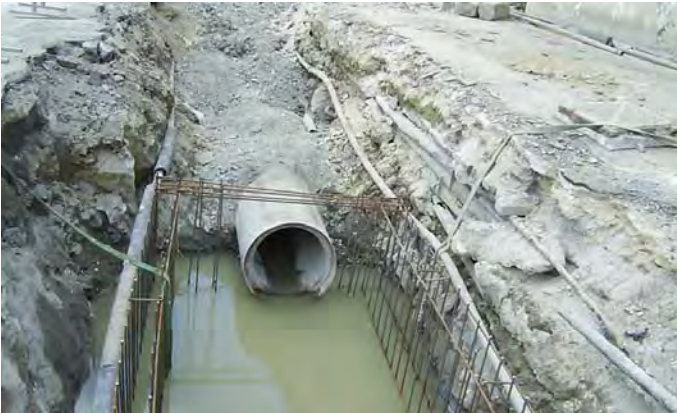
Şekil 16. RH-B07 ile RH-B05 kuyuları arasında mikrotünel kazısı terk edilerek aç-kapa yöntemi ile kazı yapılması
