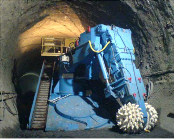
Şekil 2. Alpine WAV 178 roadheader.
