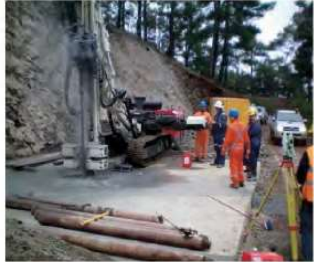
Şekil 9. Havalandırma Şaftı delgisi
