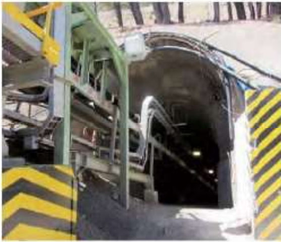
Şekil 9. Konveyör galerisi portalinden bir görünüş
