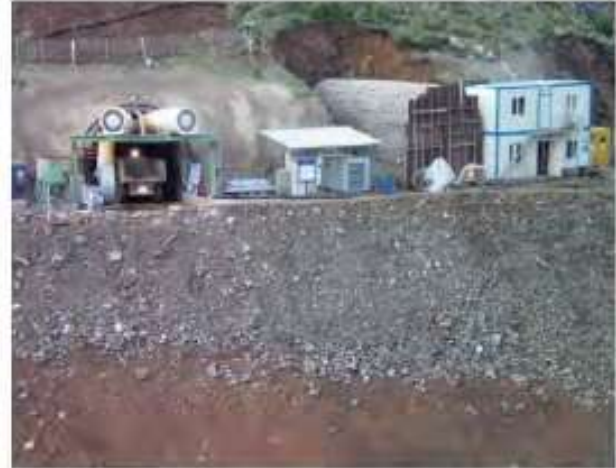
Şekil 2. Güney portal girişinden bir görünüş
