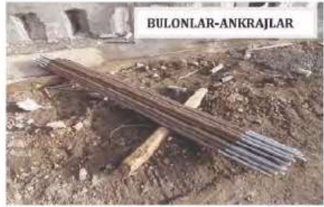
Şekil 13. Ankrajlar-Bulonlar
