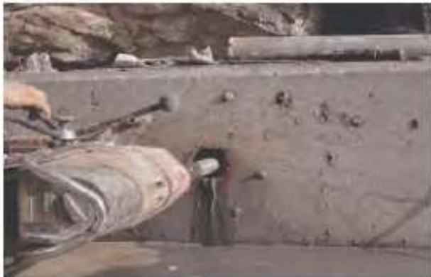
Şekil 12. Ankraj için karot delgisi
