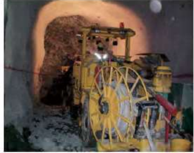
Şekil 7. Jumbo ile ayna delgisi
