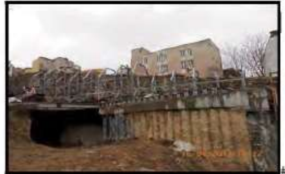
Şekil 32. Kazı-kazık ve kafes sistemi
