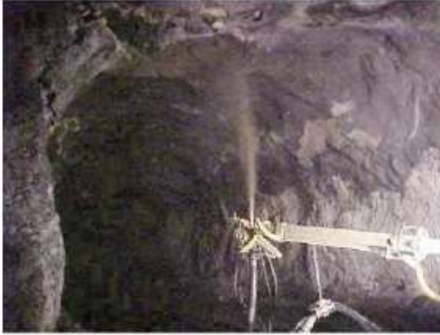
Şekil 1. Robot ile ÇTDPB uygulaması
