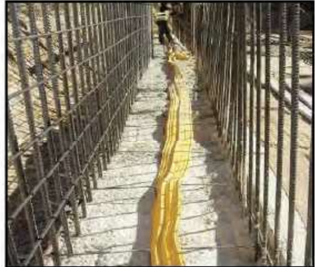
Şekil 8. PVC su tutucu uygulaması
