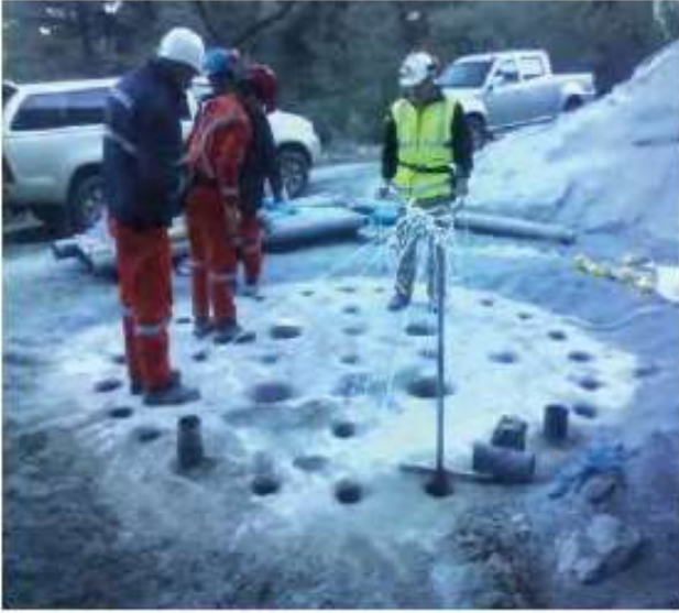
Şekil 11. Şaftın patlatma deliklerine takoz yerleştirilmiş
