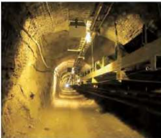
Şekil 10. Konveyör galerisinin içerisinden bir görünüş
