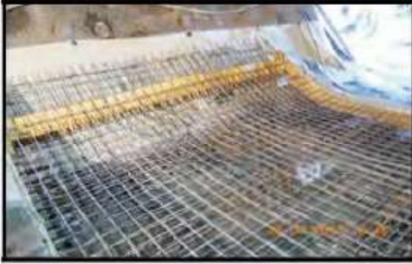
Şekil 29. Hasır çelikler
