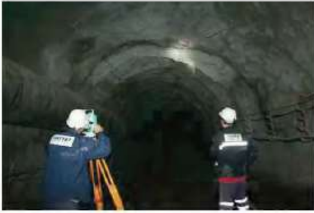
Şekil 13. Galeri içinde konverjans ölçümü
