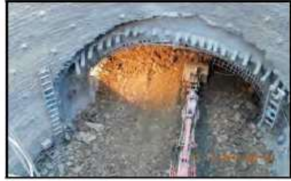
Şekil 25. Umbrella Arch borularının çakılması
