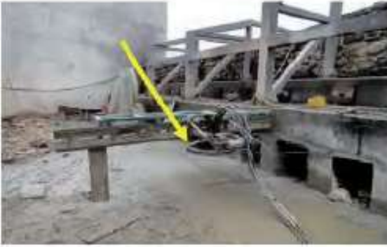
Şekil 16. Karotiyer delgisinin halatla kesilmesi(35*50*2,08cm)
