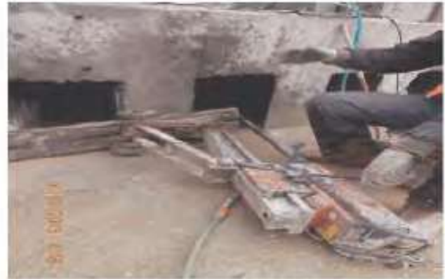
Şekil 15. Kiriş yeri için karotiyer delgisi
