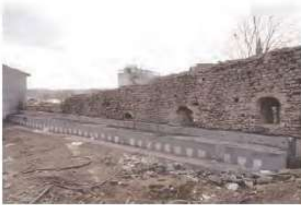
Şekil 11. L betonu görünümü
