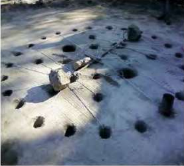
Şekil 12. Şaftın sıkılamaya hazırlanmış hali
