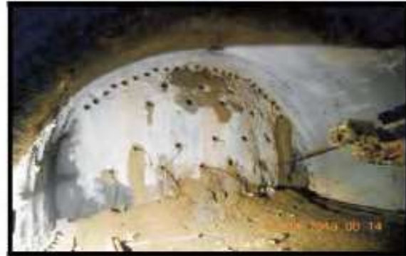
Şekil 26. Zemin çivileri delgisi çakılması
