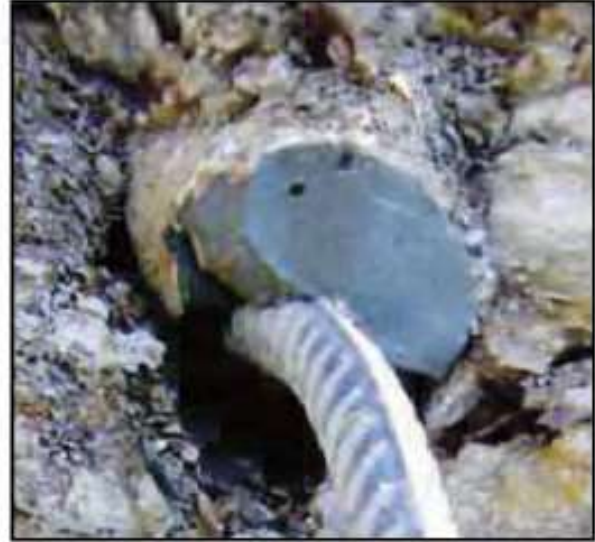
Şekil 10. Merkezleyici kullanılmamış bulon uygulaması
