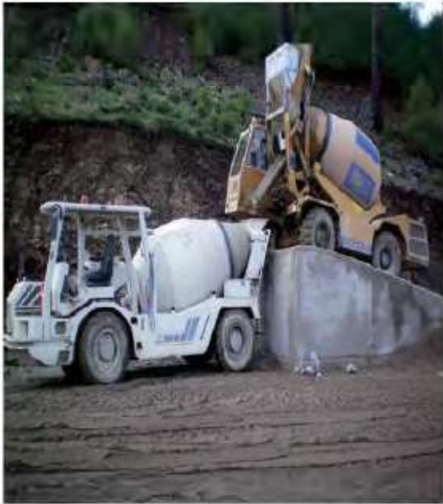
Şekil 3. Karmixle yer altı mikserine rampada püskürtme beton dolduruşundan bir görünüş
