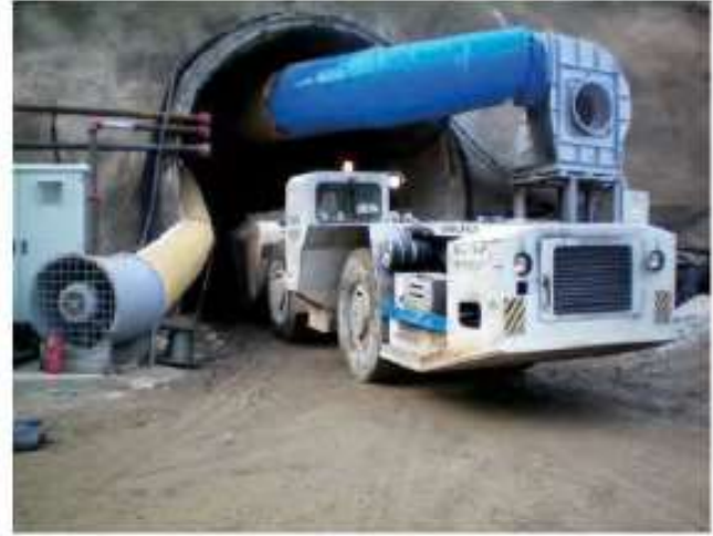
Şekil 1. Kuzey portal girişinden bir görünüş
