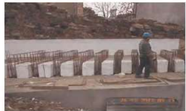
Şekil 10. Strafor ve donatı montajı
