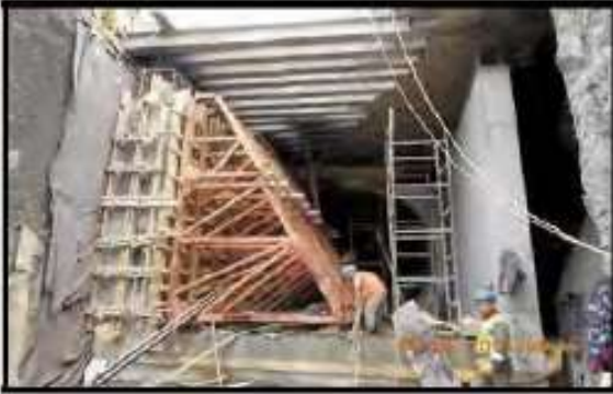
Şekil 35. Aç-Kapa perde kalıbı-betonu membran uygulaması
