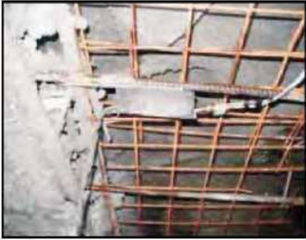
Şekil 9. Basınç hücresi uygulaması
