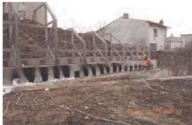
Şekil 7. Başlık Kirişi donatı montajı
