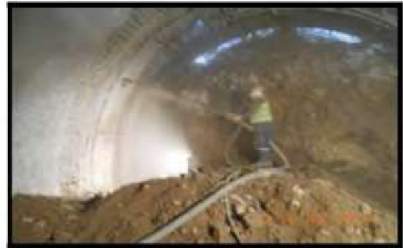
Şekil 27. Tünelden gün ışığının görünmesi
