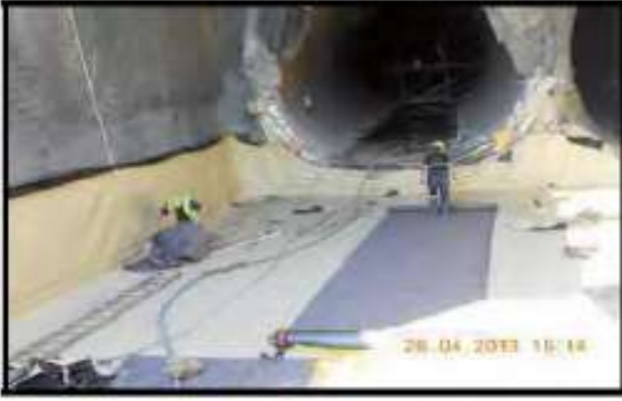
Şekil 34. Aç-kapa Tünel birleşiminde membran uygulaması
