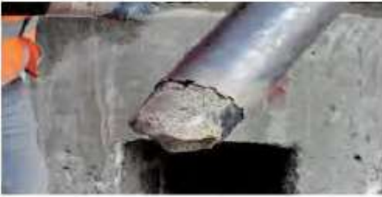
Şekil 17. Karot içindeki malzemenin boşaltılması
