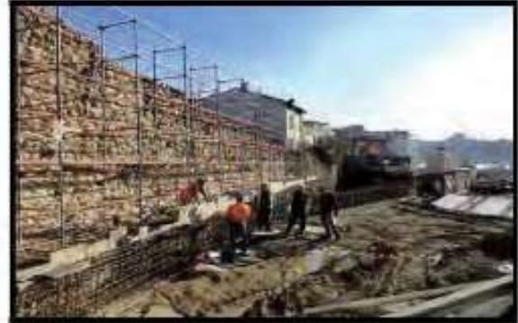
Şekil 37. Sur destek çalışması
