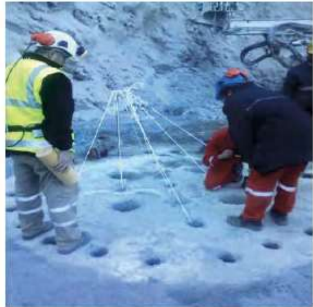
Şekil 10. Patlatma deliklerine takoz yerleştirilmesi
