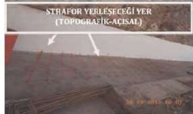
Şekil 9. Strafor yerleri
