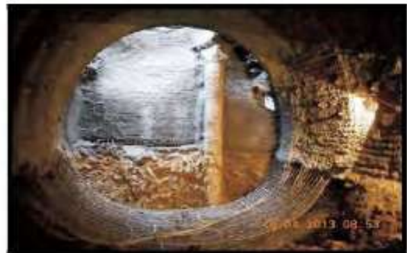
Şekil 28. Tünel, aç-kapa birleşimi ve alt yarı çalışması
