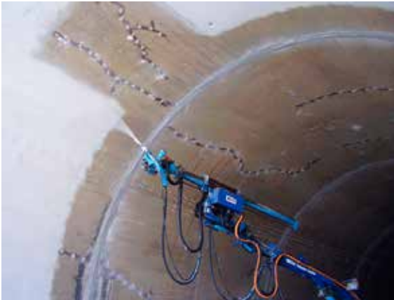
Şekil 6. Poliüre püskürtülerek yapılan su yalıtımı (Kömürlü ve Kesimal, 2012b)
