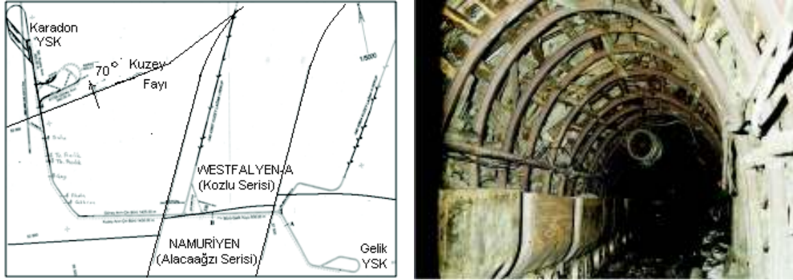
Şekil 13. Karadon TİM Kilimli İşletmesi -540 kat hazırlık planı ve doğu-batı galerisiyle Gelik Kuyusunu bağlayan ve Namuriyen yaşlı kayalarında tabakalanmaya dik doğrultuda sürülen galeri.
