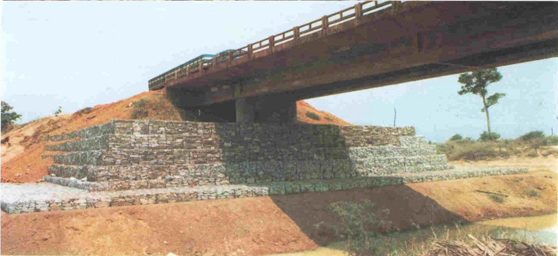
Şekil 54 Artık taşların istinat duvarları, erozyon kontrolleri, yamaç şevleri, köprü ayak kontrolleri, dere ve akarsu mecrası ıslahlarında kullanımı
