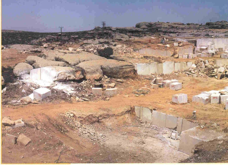
Şekil 5. Tek kademeli açık doğal taş ocağı (Toprak Mermer, Diyarbakır)
