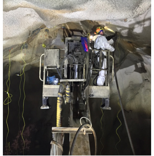
Şekil-8. Normet Charmec katarası (Slot) dolumu
