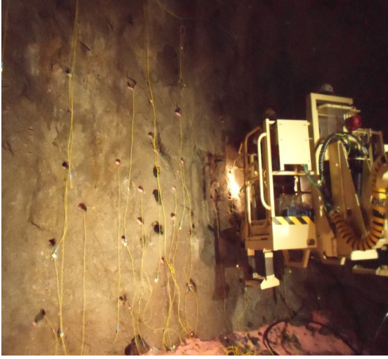
Şekil-7. Normet charmec ayna dolumu
