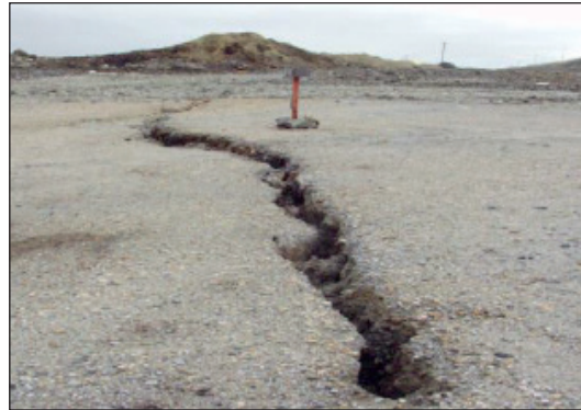
Resim 7: Ekstensometrelerle çatlak ölçümü
