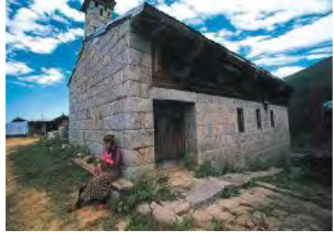
Şekil 6: Temeli ve Taşıyıcı Duvarları Blok Taştan Yapılmış Karadeniz Evi
