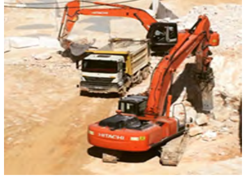
Şekil 2. Hidrolik kırıcı ve pasanın yüklenme durumu
