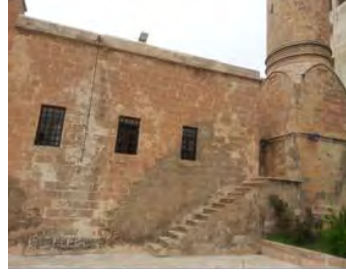
Şekil 12. Ön Cephede Çiçeklenme
