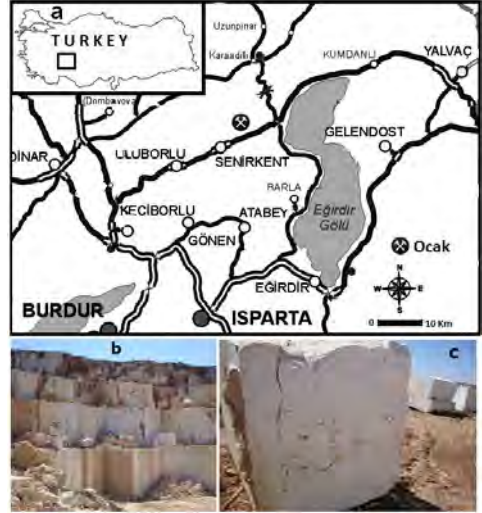
Şekil 1. Bej mermer ocağı lokasyon haritası (a), ocağın görünümü (b), çatlaklı blok görünümü (c).
