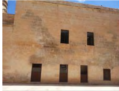
Şekil 13. Yan Cephede Çiçeklenme
