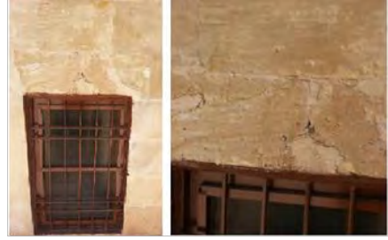
Şekil 8. Duvarda Kavlanma
