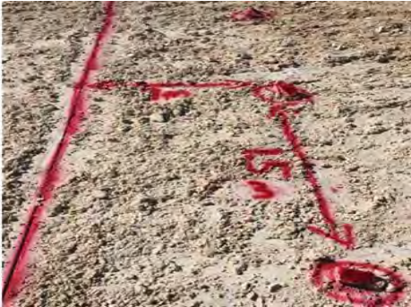
Şekil 7. Dilim kalınlığı ve delikler arası mesafe
