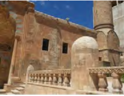
Şekil 19. Taş Yüzeyde Çimento Kullanımı
