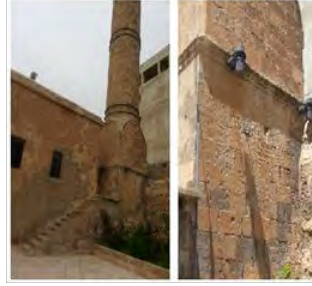
Şekil 4. Minarede Parça Kopması
