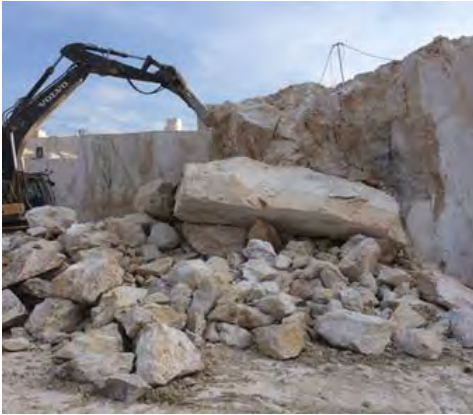
Şekil 11. Gevşetme sonrası hidrolik kırıcı ile kırma işlemleri
