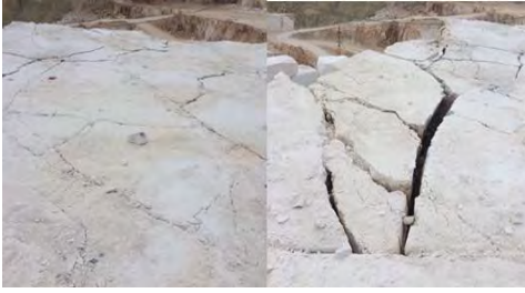
Şekil 10. Gevşetme sonrası yüzeyde oluşan çatlaklar
