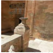
Şekil 2. Korkulukta Yüzey Kaybı
