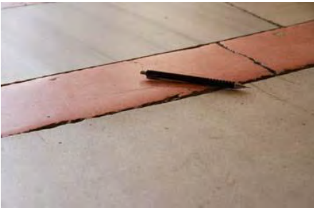
Şekil 3. Birlikte kullanılan iki taşta oluşan düzensiz aşınma
