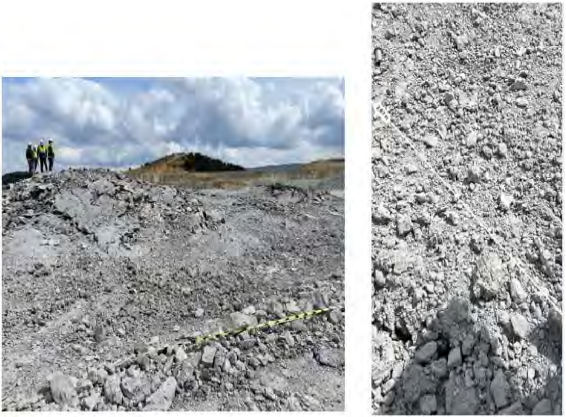
Şekil 5. Patlatma sonrası tansiyon çatlakları
