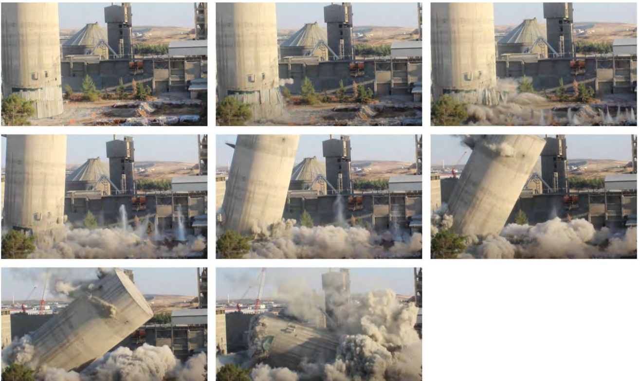
Şekil 12. 10.000 Tonluk Betonarme Silonun Kontrollü Patlatma ile Yıkılma Anı
