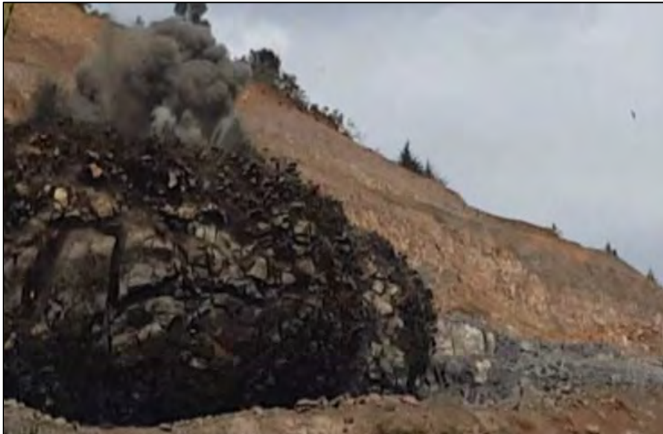
Şekil 3. Faydalı enerjinin kaya kütlelerini kırması, parçalaması ve ötelemesi.
