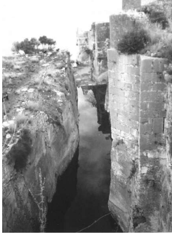
Şekil 1. Silifke-Kızkalesi (M.Ö. 4. yy.) Su hendekleri ve kale surları. Hendek duvarları için kireçtaşlarının kesilmesi ve kesilen taşların kale duvarlarında kullanılması.
