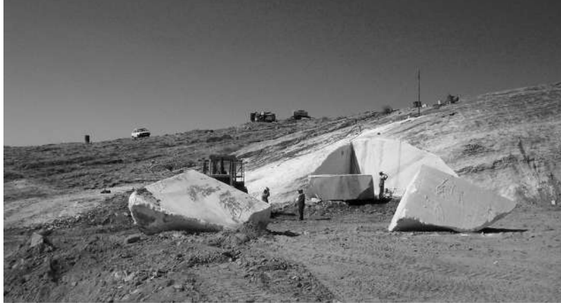
Şekil 16. Doğal taş ocağında ilk üretim öncesi hazırlık çalışmaları (üçgen kanal açma).
