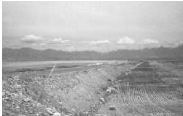
Şekil 6. Bent yapılarak atık yığınının izole edilmesi.
