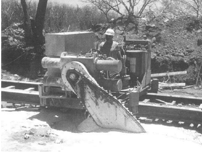
Şekil 71. Düşey kesim yapabilen bir kollu zincirli kollu kesici makina.
