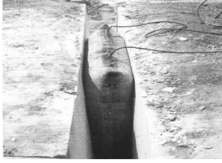
Şekil 57. Kesilen kütleyi arda kayaçtan ayıran hava yastığı.
