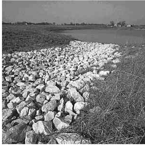
Şekil 8. Drenaj kanalında bir riprap uygulaması (Boyer Madeni, ABD).
