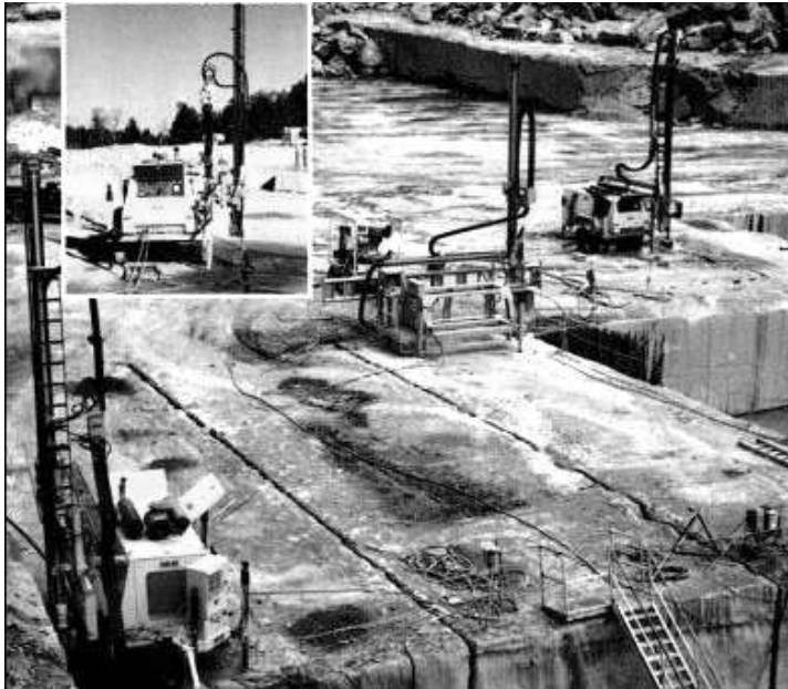
Şekil 80. Su jeti ile üretim yapılan bir granit ocağının genel görünümü
