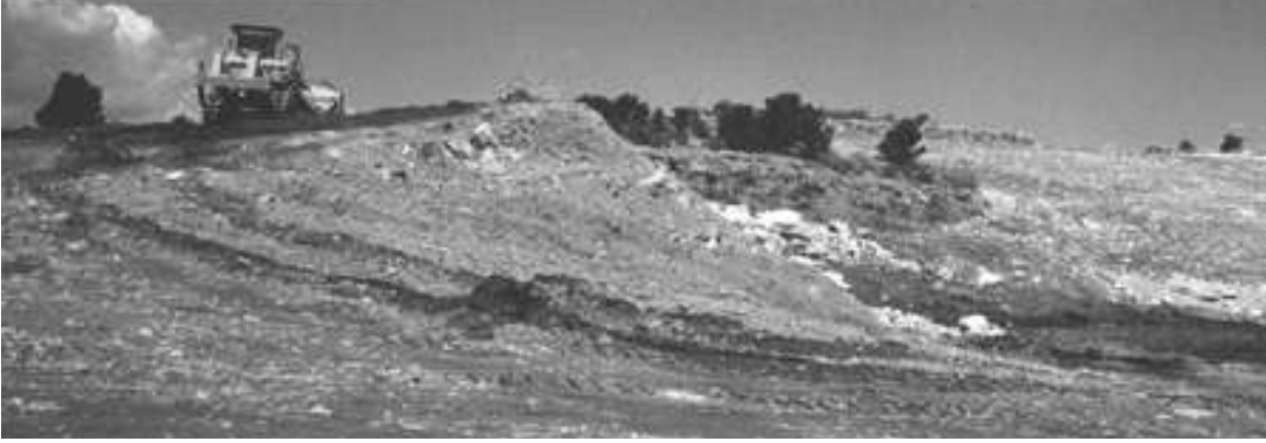
Şekil 9. Üst toprağın selektif şekilde sıyırılması.
