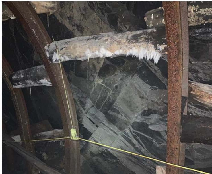
Şekil 10. Akkurt Madencilik 4 Nolu Ocak Ana Nakliye Galerisine Ahşap Tahkimatın rutubete maruz kalmış halinin örneği.
