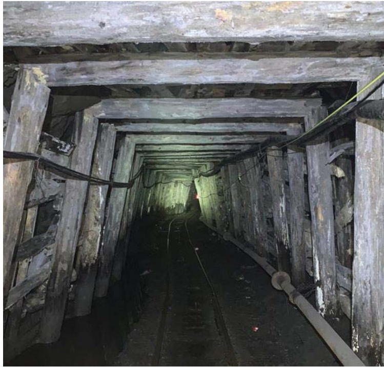
Şekil 2. Akkurt Madencilik 4 Nolu Ocak Ana Nakliye Galerisi Ahşap Tahkimat Uygulanılmış Kısım.
