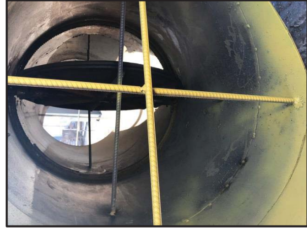
Şekil 5. Damperin açık görünümü
