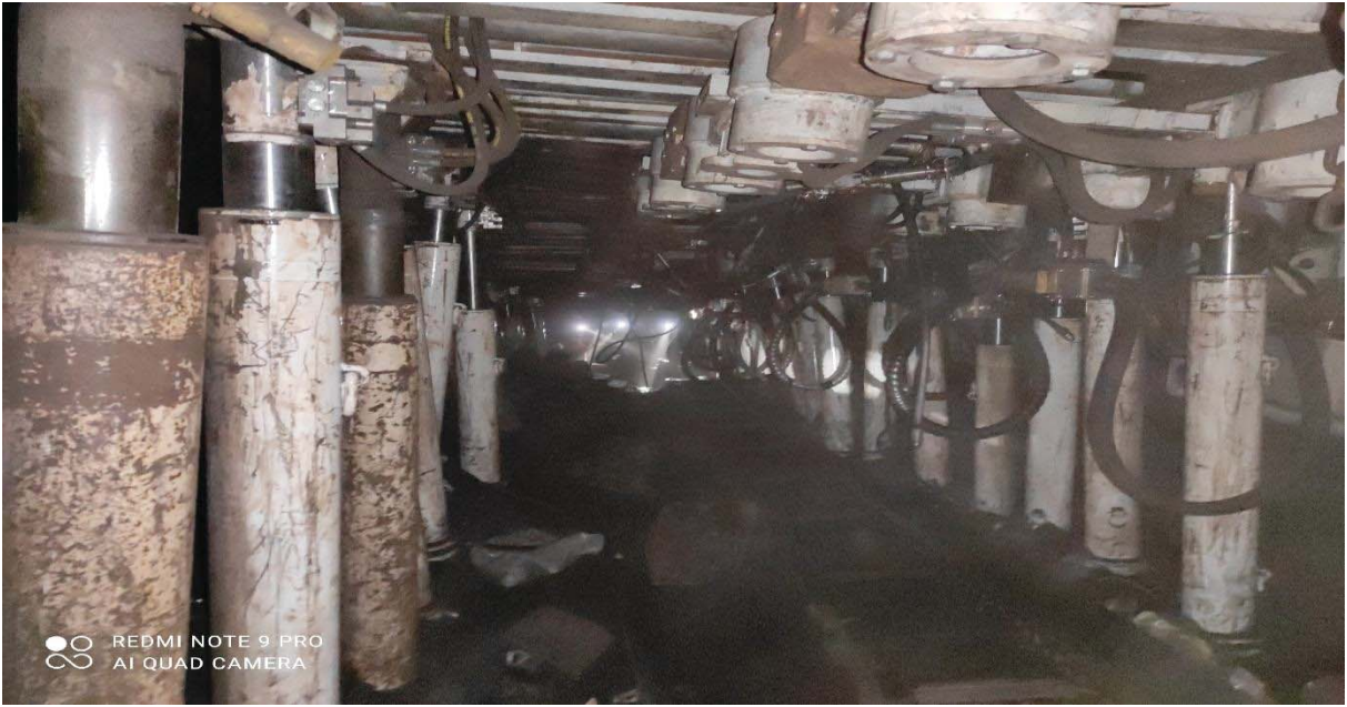
Şekil 4. Kirişli tip tahkimat sistemi.
