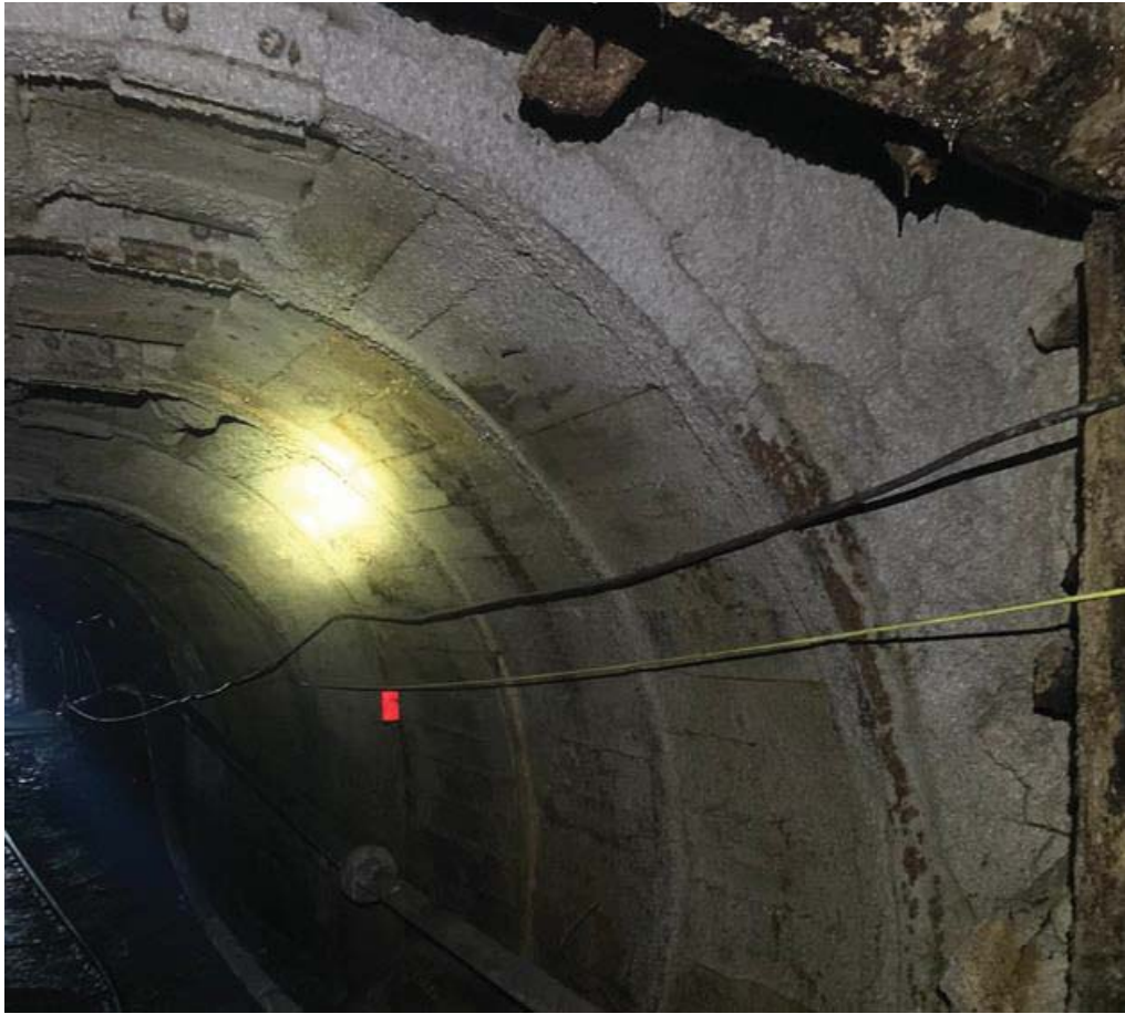
Şekil 4. Akkurt Madencilik 4 Nolu Ocak Ana Nakliye Galerisi Püskürtme Beton Uygulanılmış Kısım.
