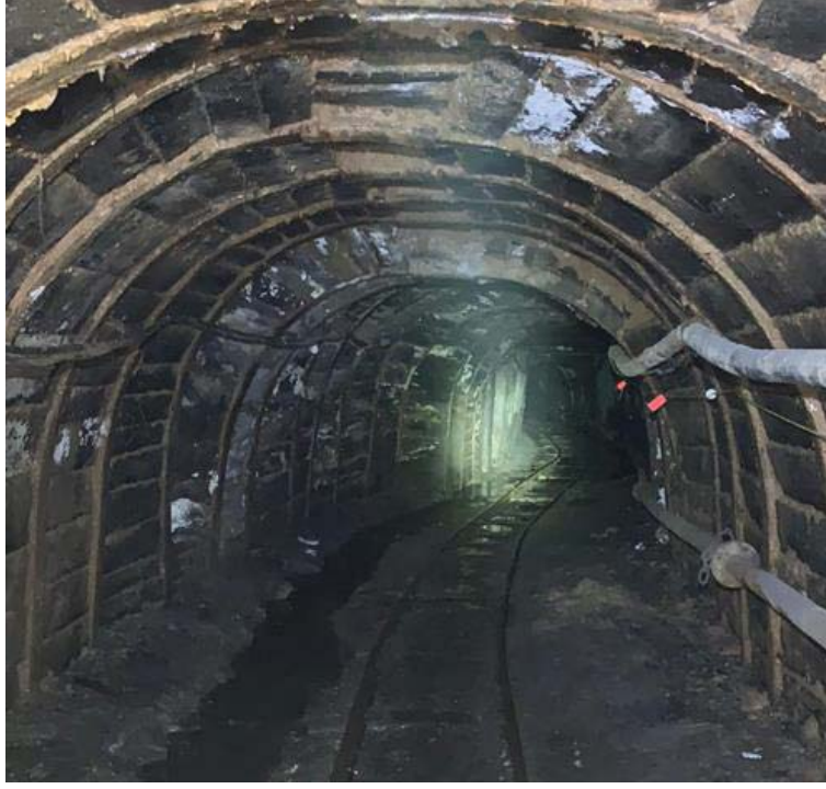
Şekil 5. Akkurt Madencilik 4 Nolu Ocak Ana Nakliye Galerisi Demir Bağ ve Beton Uygulanılmış Kısım.
