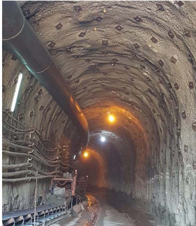
Şekil 11. Sapanca-Geyve Yüksek Hızlı Tren Projesi Güvenlik Tüneli 5 ten genel görünüm.
