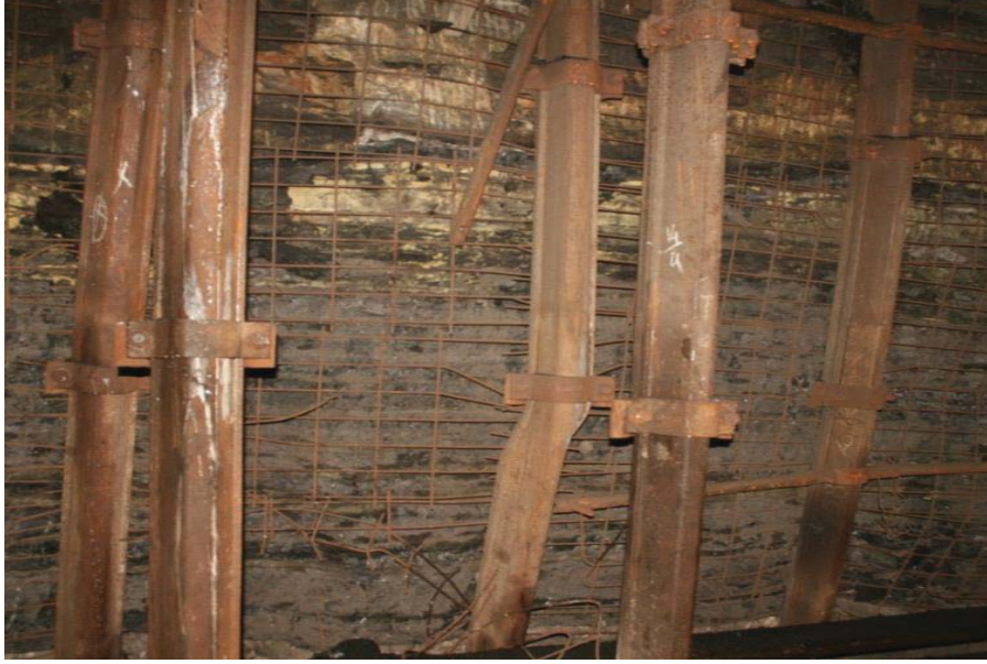
Şekil 7 Hatalı torklama (aşırı sıkılama) nedeniyle kayamadan burkulan TH çelik bağ.
