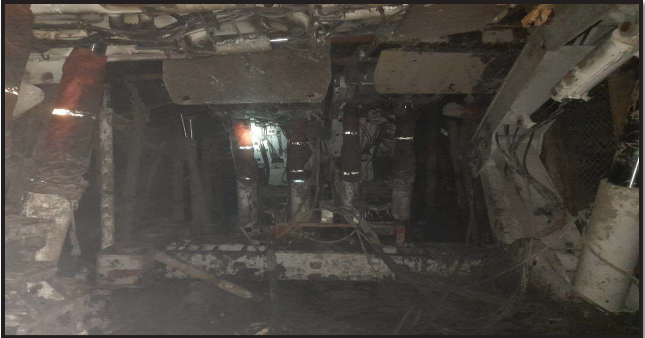
Şekil 11. Emniyet aparatlarının montaj fotoğrafı.
