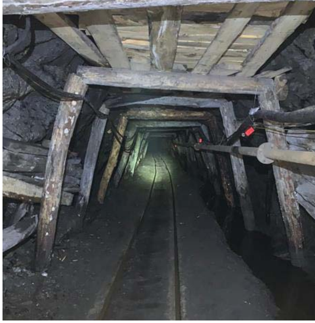
Şekil 7. Akkurt Madencilik 4 Nolu Ocak Ana Nakliye Galerisi Ahşap Tahkimat Uygulanılmış Kısım.
