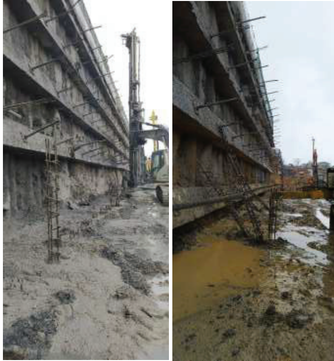
Şekil 18. Kotuna indirilemeyen mini kazık donatı kafesleri
