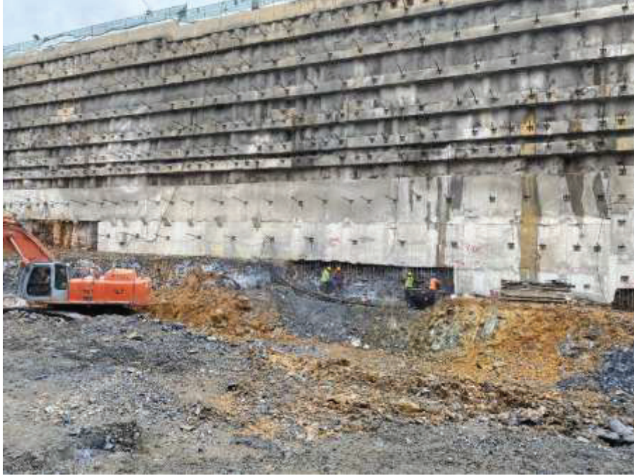
Şekil 19. Mini kazık önüne ankrajlı betonarme perde yapılması
