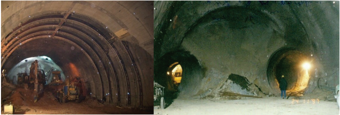
Şekil 1. Bernold kaplaması ve alt yarı pilot tünel yöntemi
