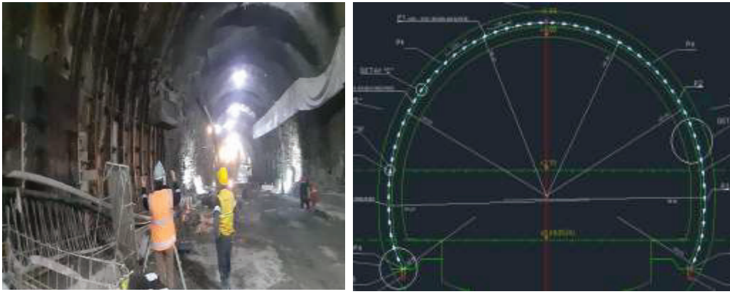
Şekil 10. Ara kaplama alt yarı iksa montajı
