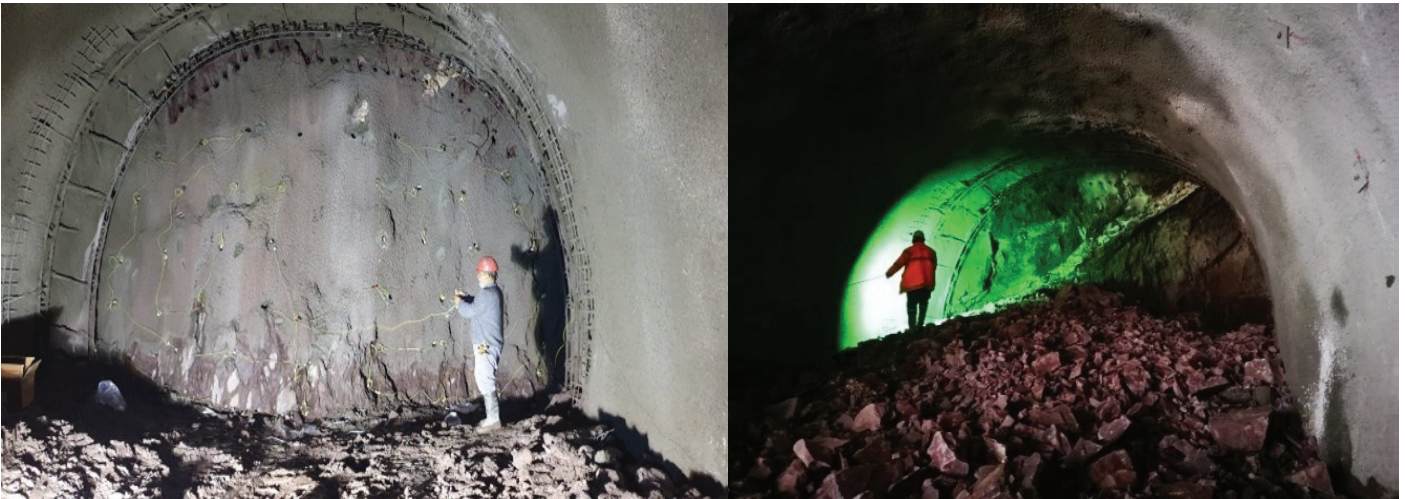
Şekil 10. Anahat tünelleri atım fotoğrafları (atım öncesi ve sonrası)
