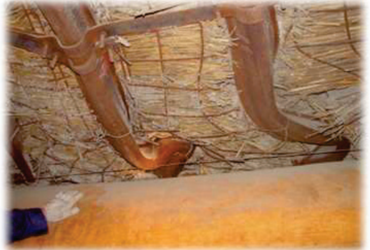
Şekil 3. U çelik profilde gözlenen deformasyon (He ve Sousa, 2012)
