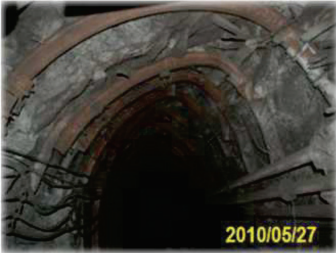
Şekil 3. U çelik profilde gözlenen deformasyon (He ve Sousa, 2012)
