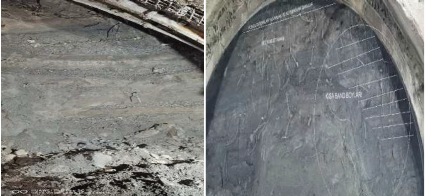
Şekil 2. T1 tüneline ayna fotoğrafı
