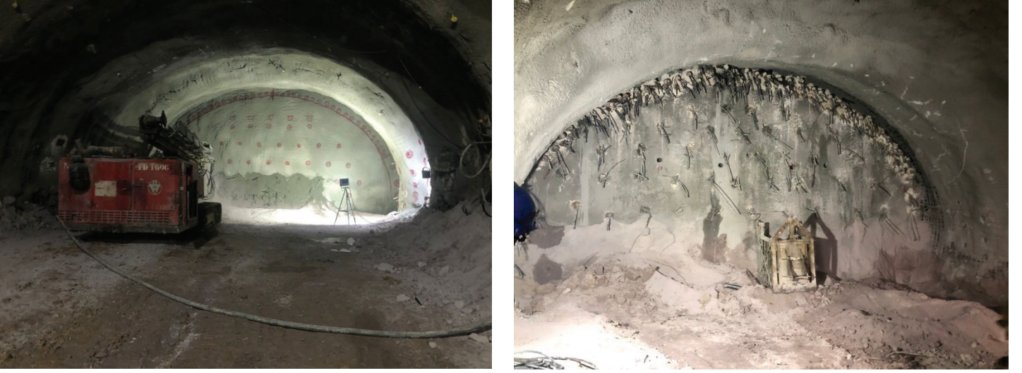
Şekil 12. ÇSS projesi peron tüneli (P1) boru kemer uygulaması
