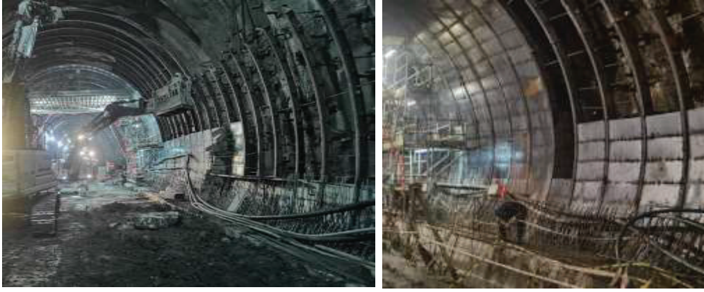
Şekil 10. Ara kaplama üst yarı iksa montajı
