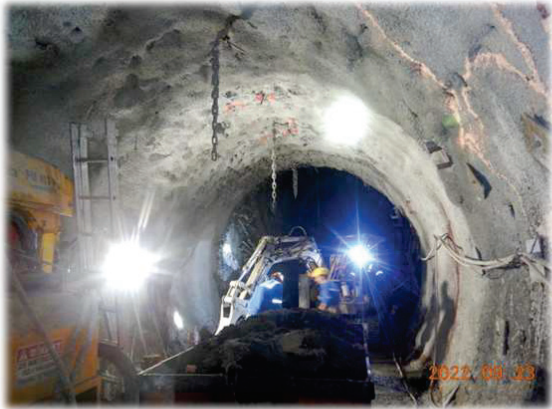
Şekil 14. Tarama galerisi/tüneli tasarım projesinin uygulanmış hali
