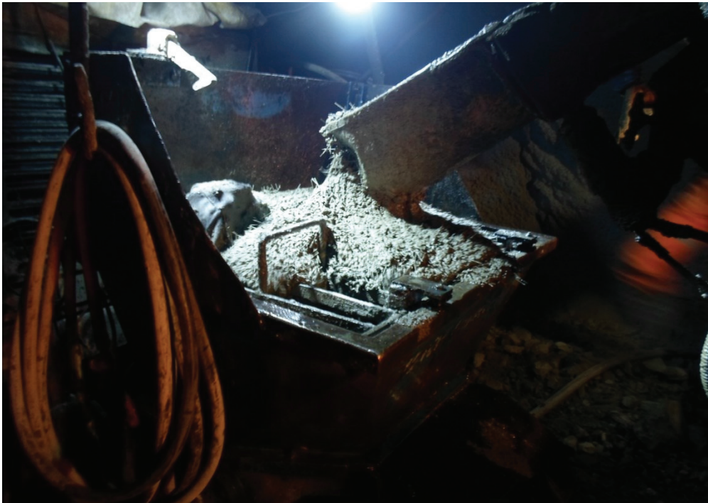
Şekil 3. Fiberli beton besleme
