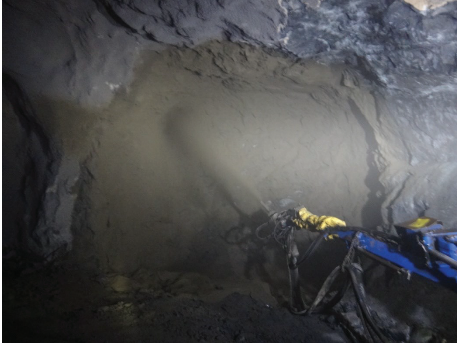
Şekil 1. Püskürtme beton uygulaması
