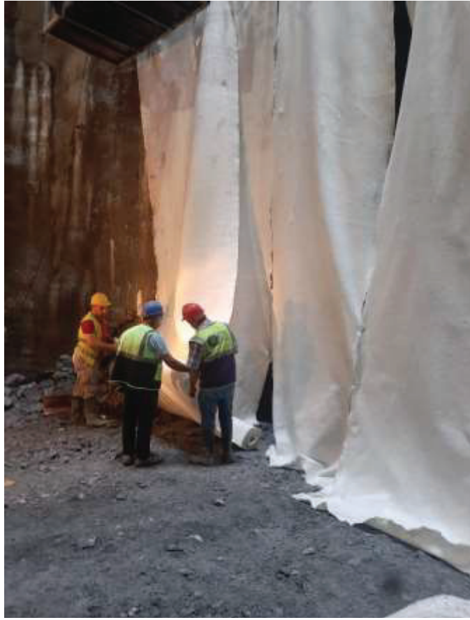
Şekil 5. Hava şokunu minimize etmek için perde uygulaması
