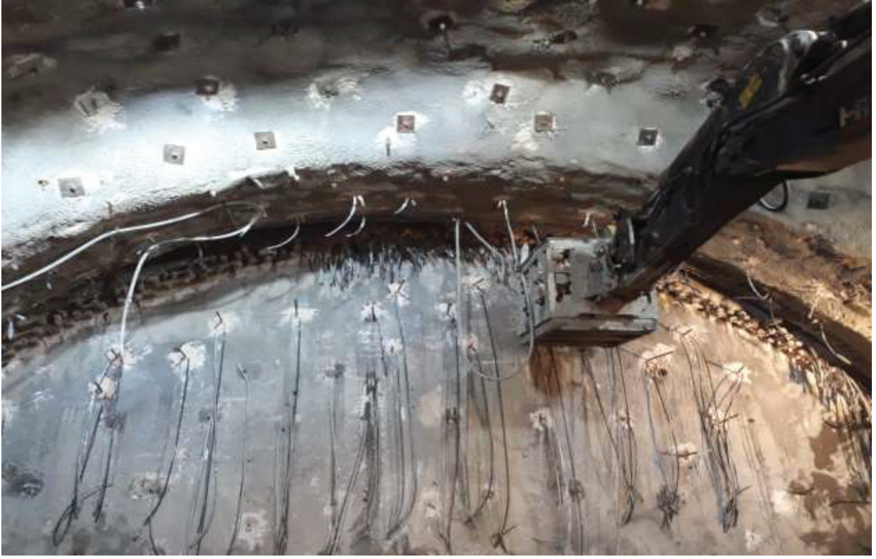
Şekil 19. T2 tüneline ayna zemin çivisi uygulaması
