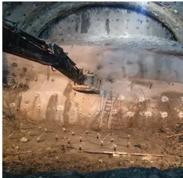
Şekil 10. İnvirt aşamasında oturma kazığı uygulaması
