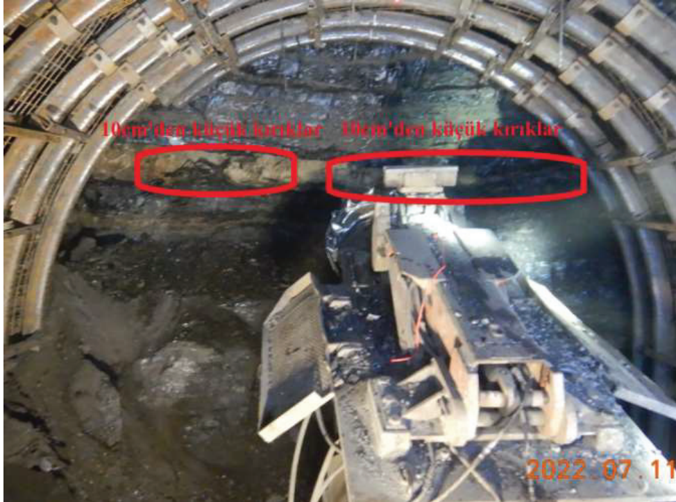
Şekil 1. Arında 10cm'den küçük kırıkları içerir alan
