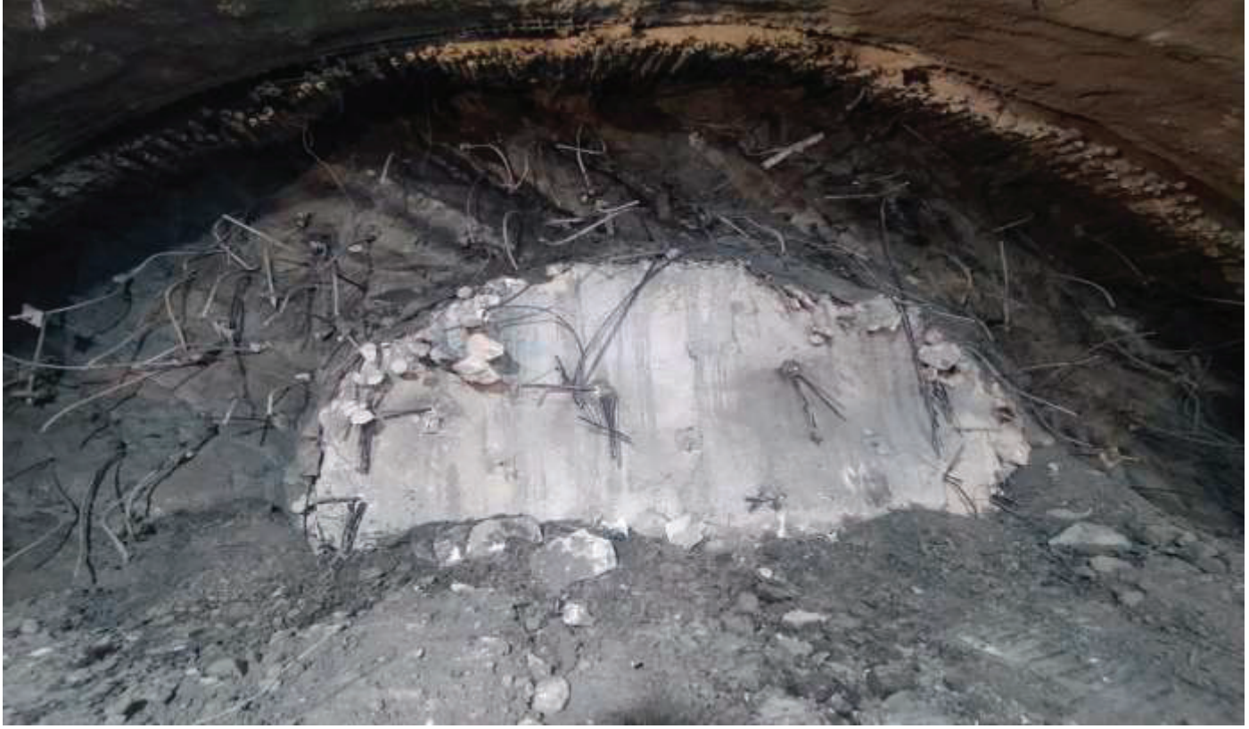
Şekil 5. Aynadaki tabakaların ve formasyonun görünümü
