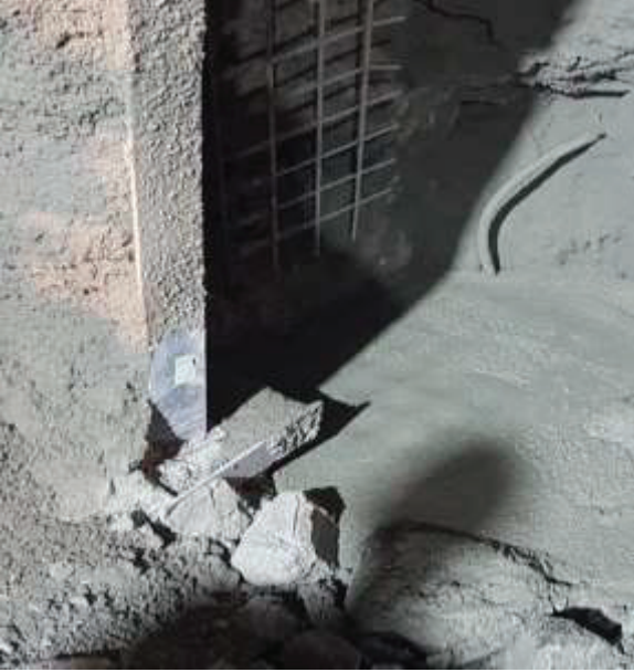
Şekil 13. Üstyarı iksa mütemudi giriş uygulaması
