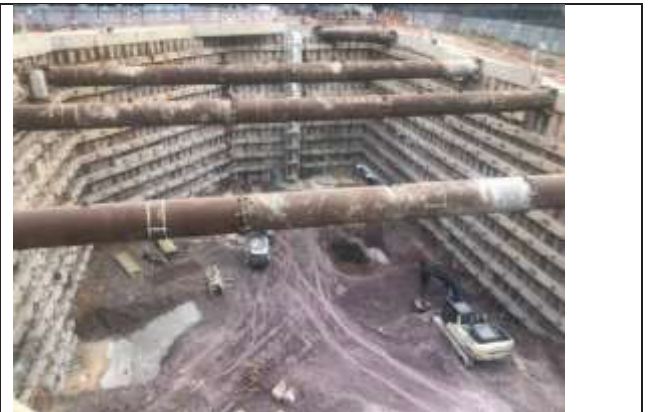
Şekil 23. Sahada Strut Uygulaması
