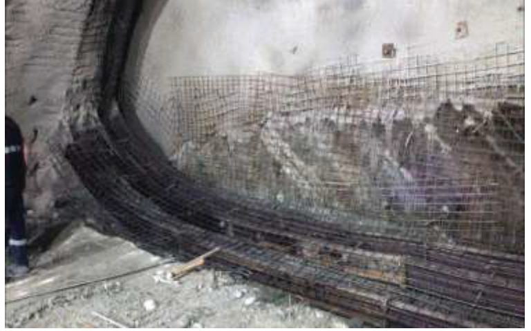
Şekil 17. Üstyarıda uygulanan dışa kavis oluşan geçici invert
