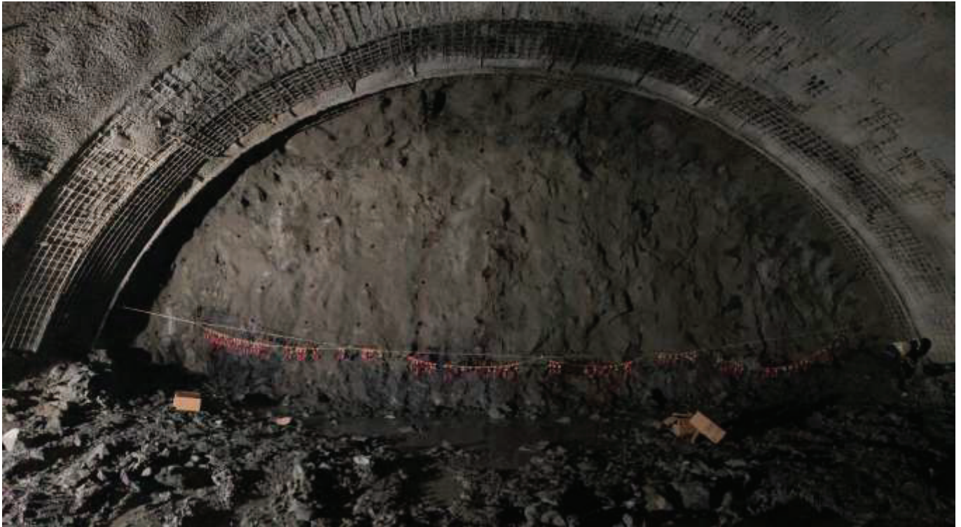
Şekil 4. Elektronik kapsüllerin ayna boyunca hat üzerindeki görünümü
