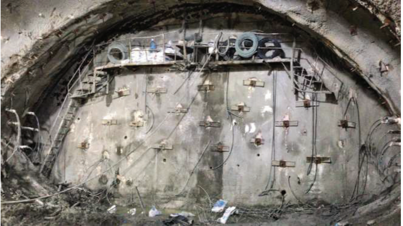
Şekil 20. T2 tüneline enjeksiyon priz sonrası profil destekleme
