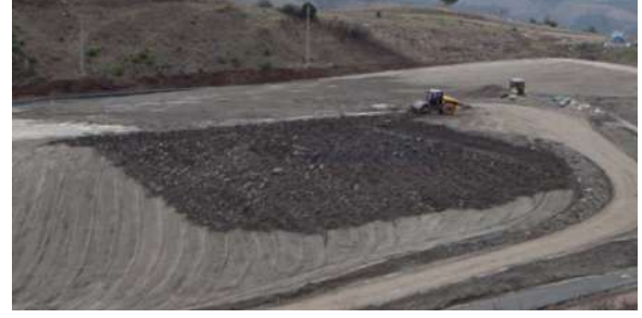
Şekil 8. Nemini azaltmış olan alanın tekrar serilerek sıkıştırılması.
