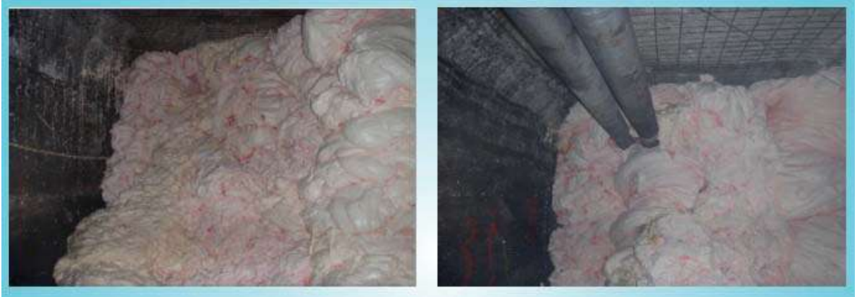
Şekil 7: Yerüstünden yeraltı galeri dolgusu sonrası görseller (Wilson Mining Service, 2019)
