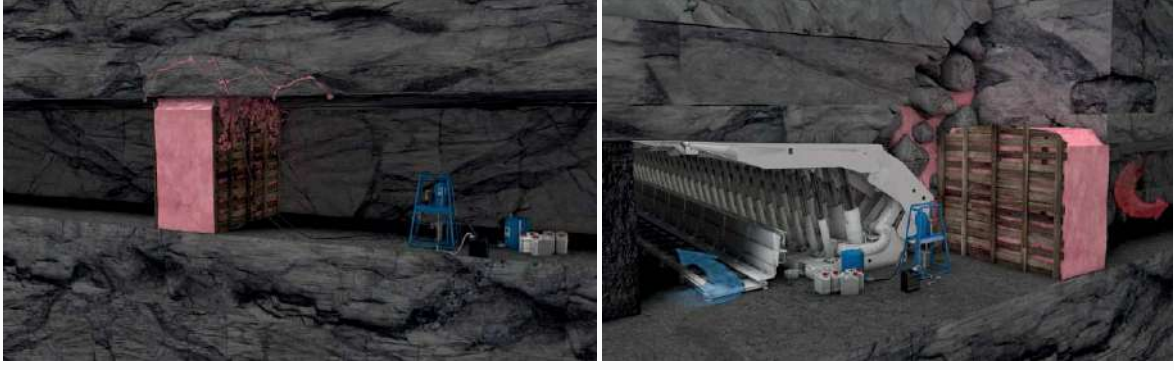
Şekil 4: Havalandırma yönetimi için kimyasal köpük ürünleri ile hava kapılarının yapılması (Weber Madencilik, 2019)
