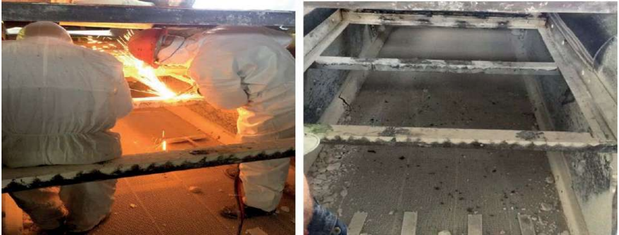
Şekil 8. Çelik esaslı elek panel şasesinin kesilerek demontajı anı görünümü
