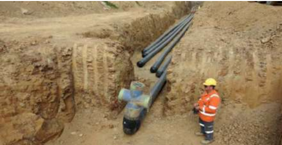
Şekil 18. Su borusu döşeme işleri
