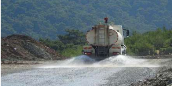
Şekil 26. Atık nakliye yolunda toz bastırma amacı ile arazöz kullanılması
