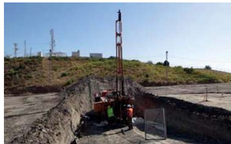
Şekil 34. Filtrelenmiş atık depolama alanı'nda SPT çalışması
