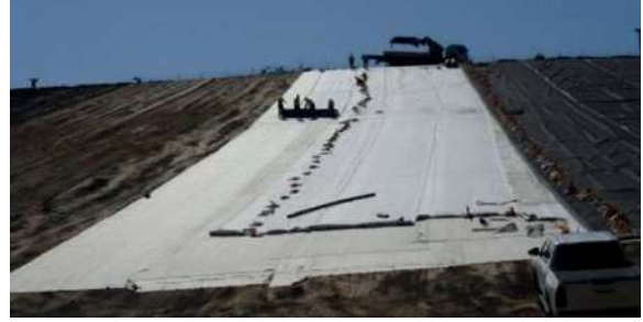
Şekil 3. Filtrelenmiş atık depolama alanı geçirimsizlik sistemi inşaatından bir görünüm
