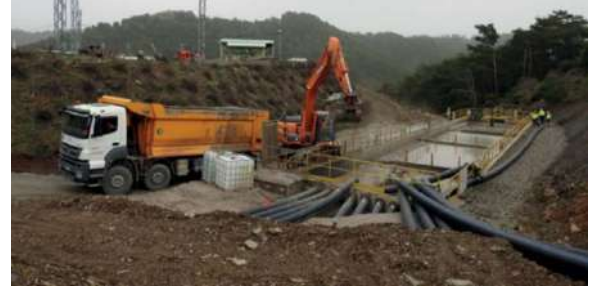
Şekil 16. Sediman yakalama havuzundan çamur temizliği yapılması
