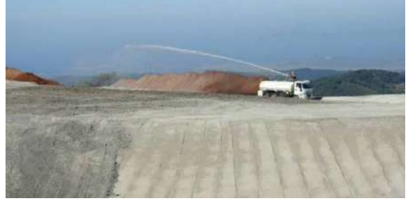
Şekil 27. Filtrelenmiş atık depolama alanının üstten püskürtme ile sulanması
