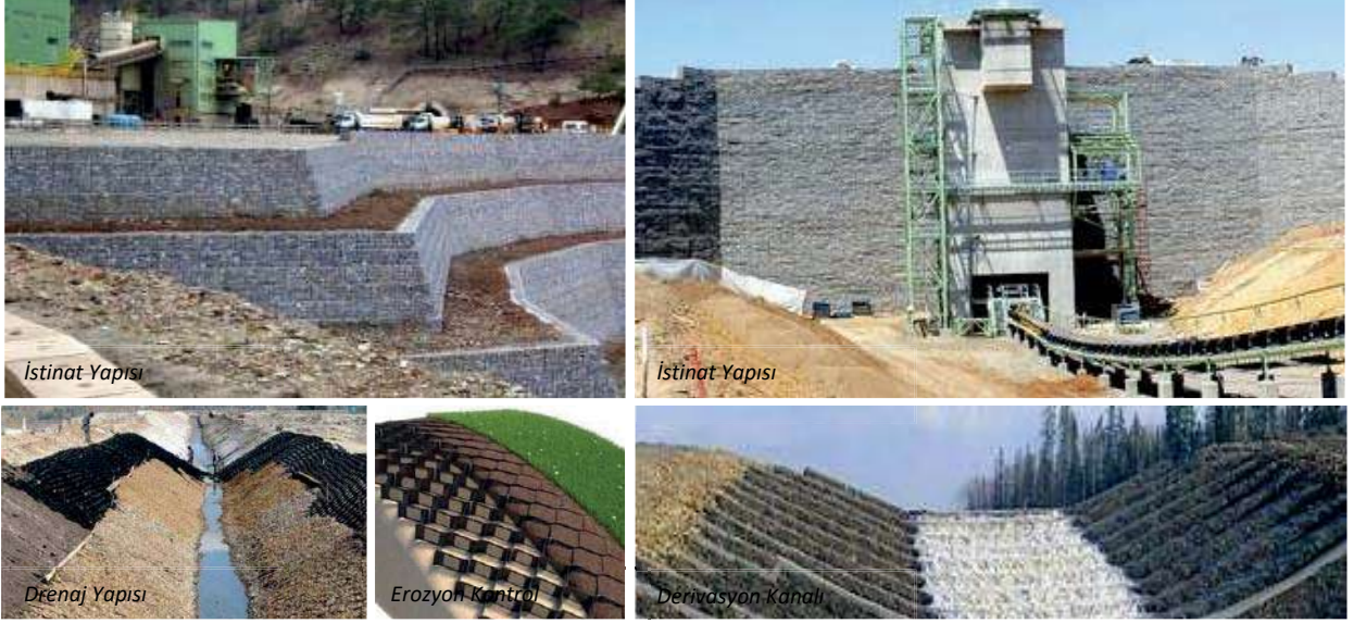
Şekil 6. Madencilik faaliyetlerinde jeosentetik malzemeler
