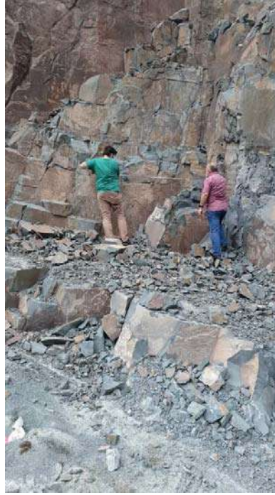
Şekil 11. Taş ocağında yapılan hat etüdü çalışmalarından bir görünüm
