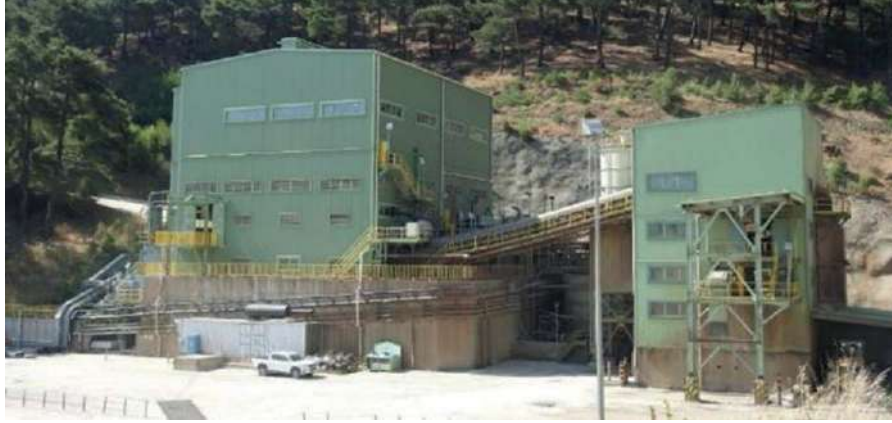
Şekil 1. Efemçukuru Madeni filtre tesisi
