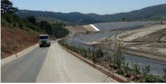
Şekil 28. Asfalt kaplamalı nakliye yolu
