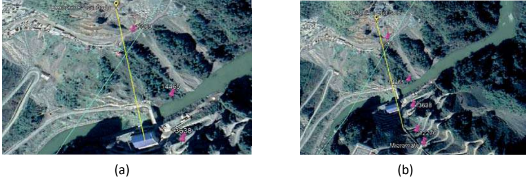
Şekil 2. a) Elektronik grup patlatma ve Darıca-2 HES arasındaki mesafe, b) Elektronik grup patlatma ve Cebri boru hattı arasındaki mesafe 10.07.2021
