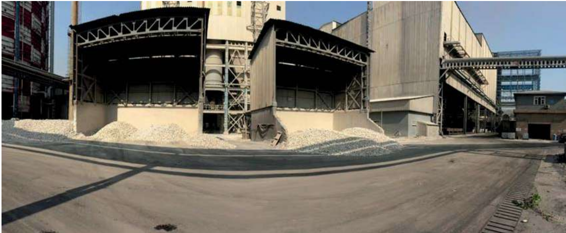
Şekil 3. Kardemir A.Ş. kireç fabrikasında bulunan kireç taşı yer altı bunkerleri genel görünümü
