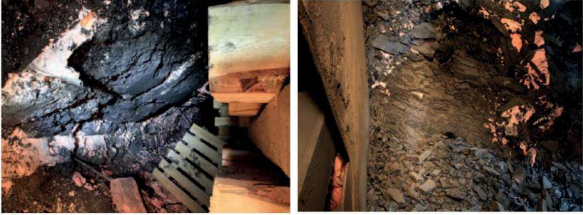
Şekil 3: Kimyasal köpük uygulamaları ile göçük stabilizasyonu (Pile, 2013)
