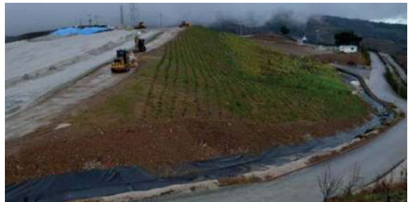
Şekil 31. Nihai duruma ulaşan yüzeylerde yapılan rehabilitasyon işlemi
