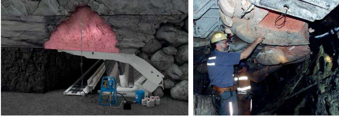
Şekil 1: Ayak içi yürüyen tahkimat üzeri boşlukların köpük ile doldurulması (Weber Kataloğu, 2019; Frith, 2006)
