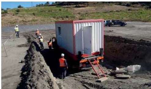
Şekil 33. Filtrelenmiş atık depolama alanı'nda SPT çalışması
